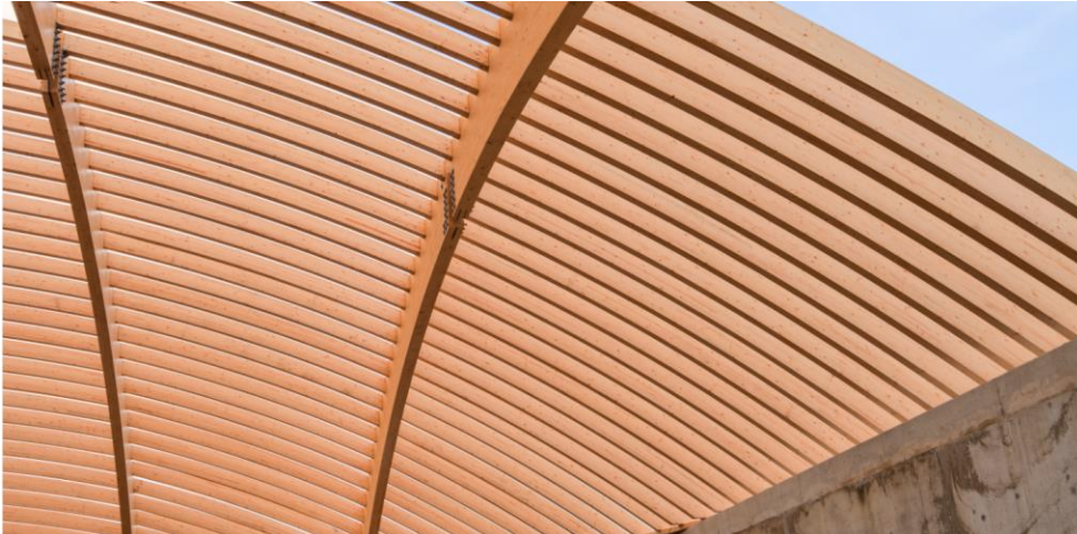
Abbildung 11: Blick von unten während Montage (Bottom Ash)
