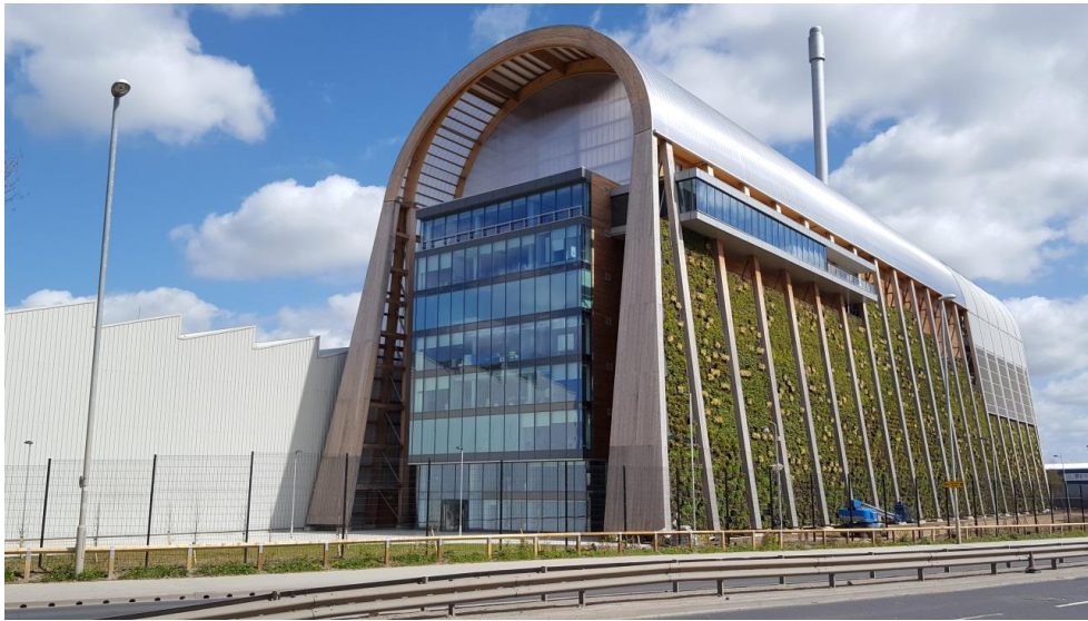
Abbildung 1: Hightech-Müllverbrennungsanlage (Quelle: http://www.letsrecycle.com )
