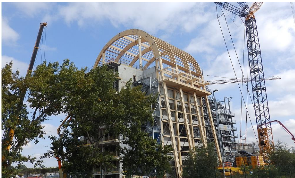
Abbildung 14: Montagezustand ERF (4 Achsen montiert)
