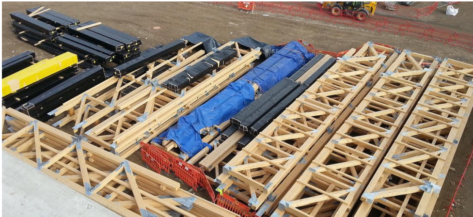
Abbildung 9: MPT/TIH vormontierte Fachwerkbinder
