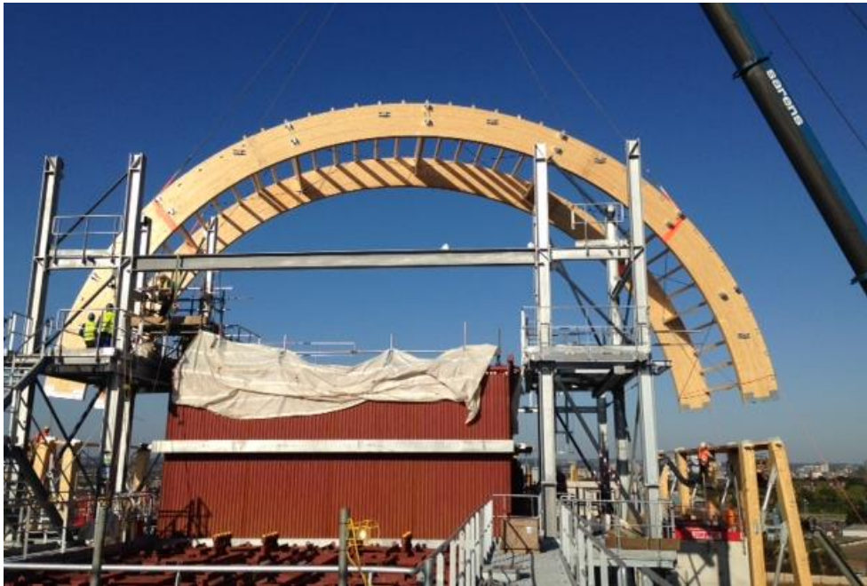
Abbildung 13: ERF / Einheben von 2 Bogenbinderpaaren
