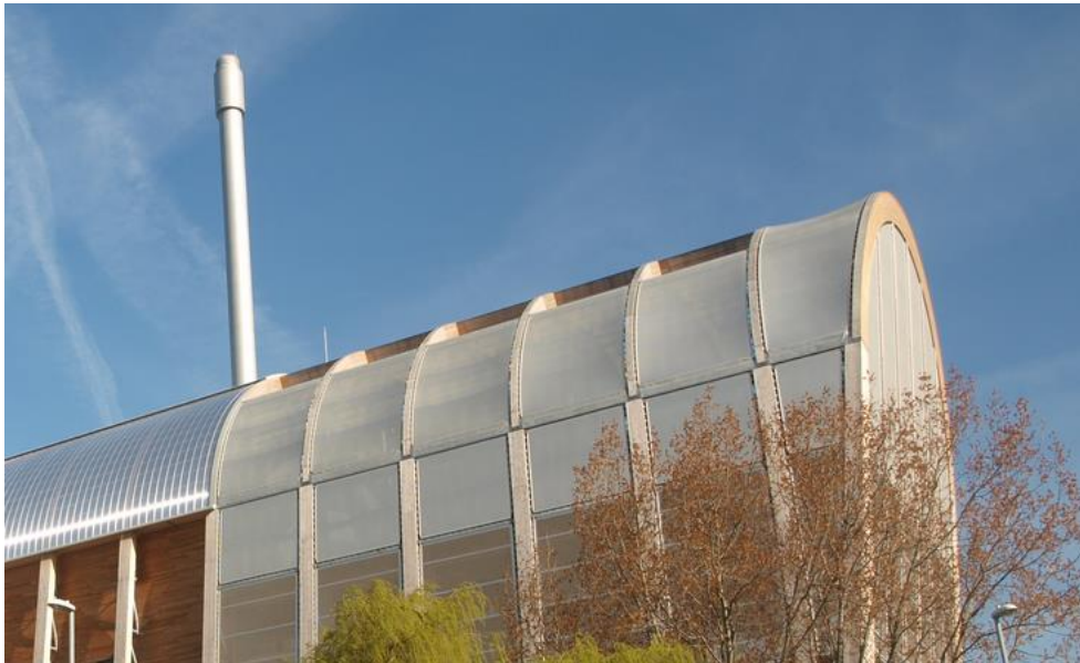
Abbildung 7: Südostbereich des Daches mit Metallgewebe verkleidet (Bildquelle: http://www.biotope.uk.com )
