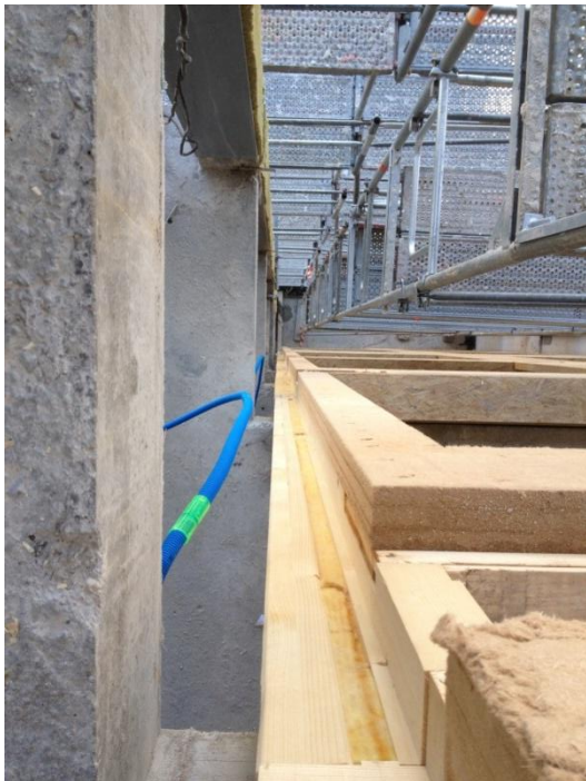
Figure 5 : Pose de la paroi entre échafaudage
