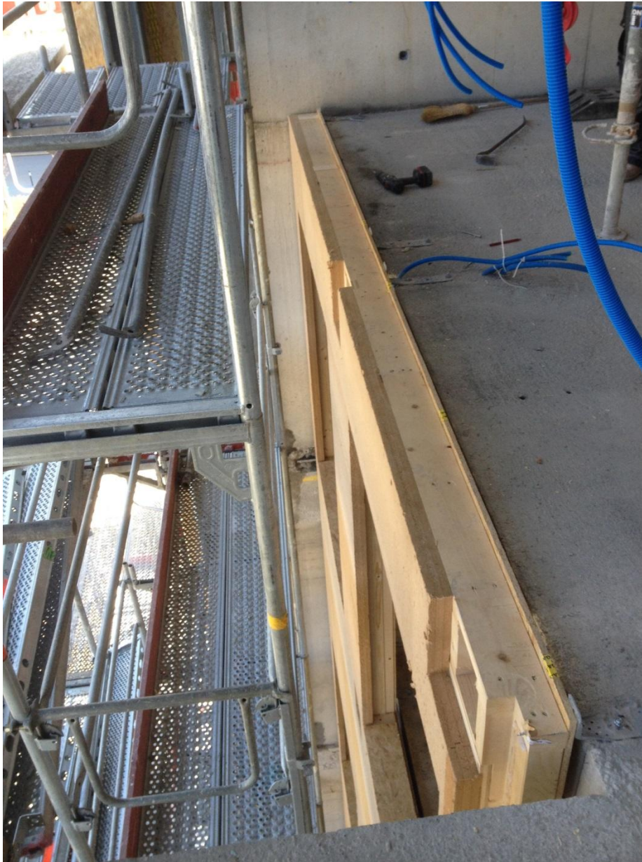
Figure 4 : Système de fixation des parois
