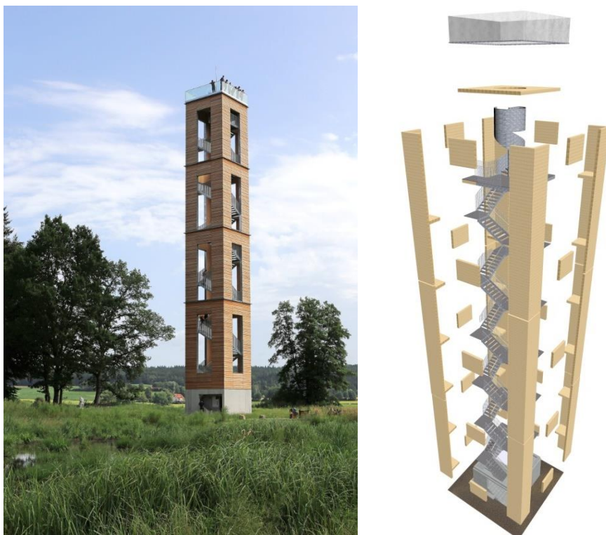
Abbildung 5: Bannwaldturm Ostrach, Ansicht und Explosionszeichnung
