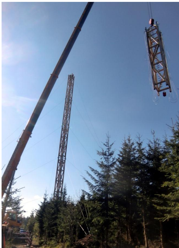
Abbildung 11: Aufbau des Windmessmasten mit einem Autokran
