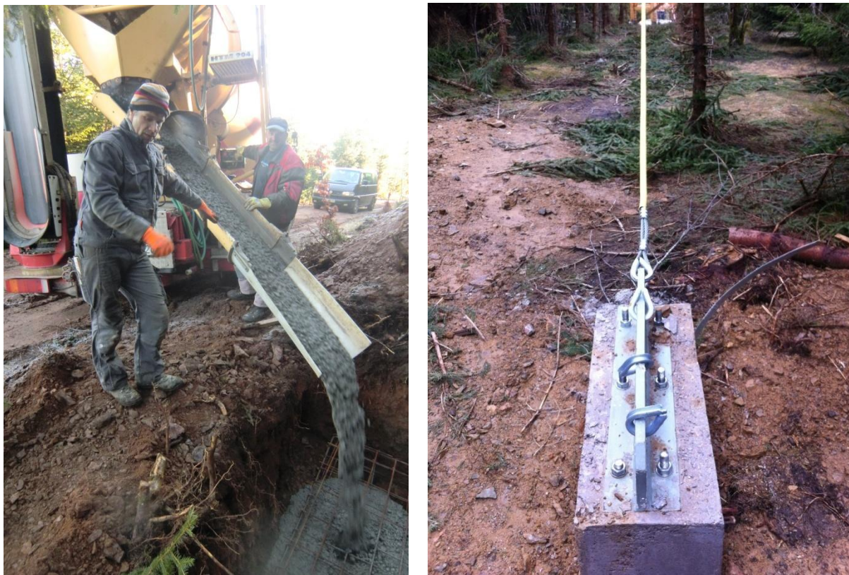
Abbildung 7: Erstellung der Fundamente; Ankerpunkte für die Abspannseile
