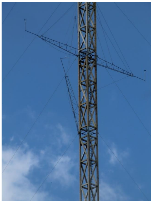
Abbildung 12: Aufsetzen des Tops (oberstes Element); ausklappbare Ausleger
