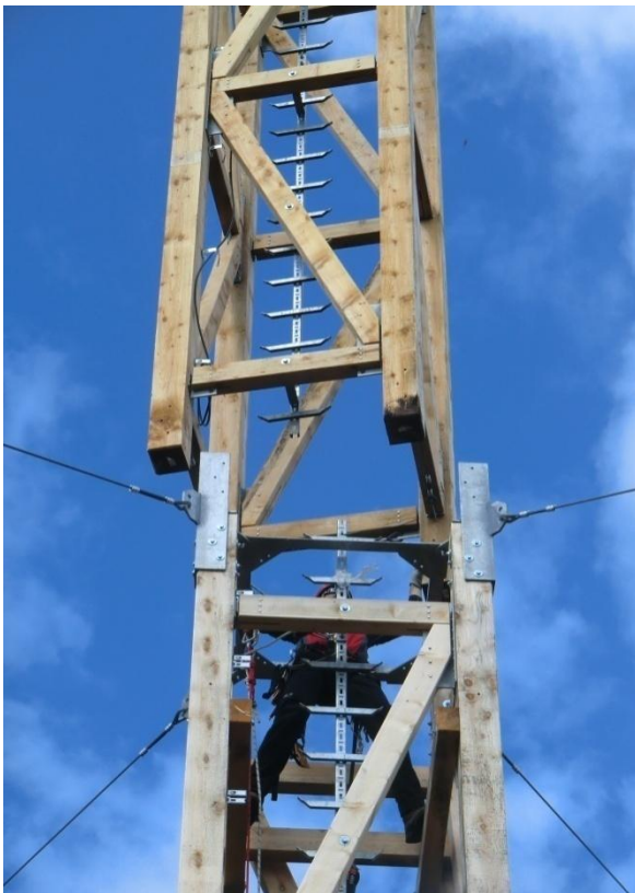
Abbildung 10: Aufeinandersetzen der Segmente; Befestigung der Abspannseile
