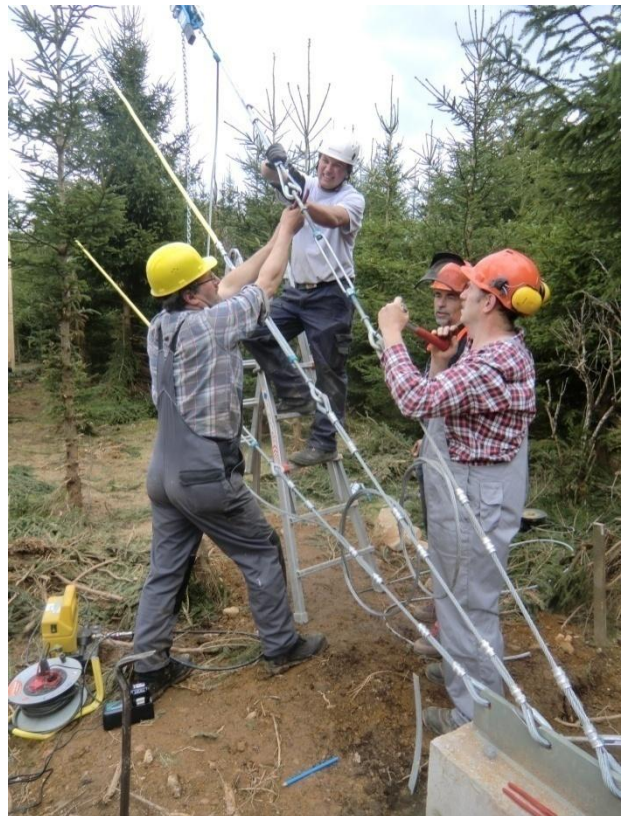
Abbildung 10: Aufeinandersetzen der Segmente; Befestigung der Abspannseile
