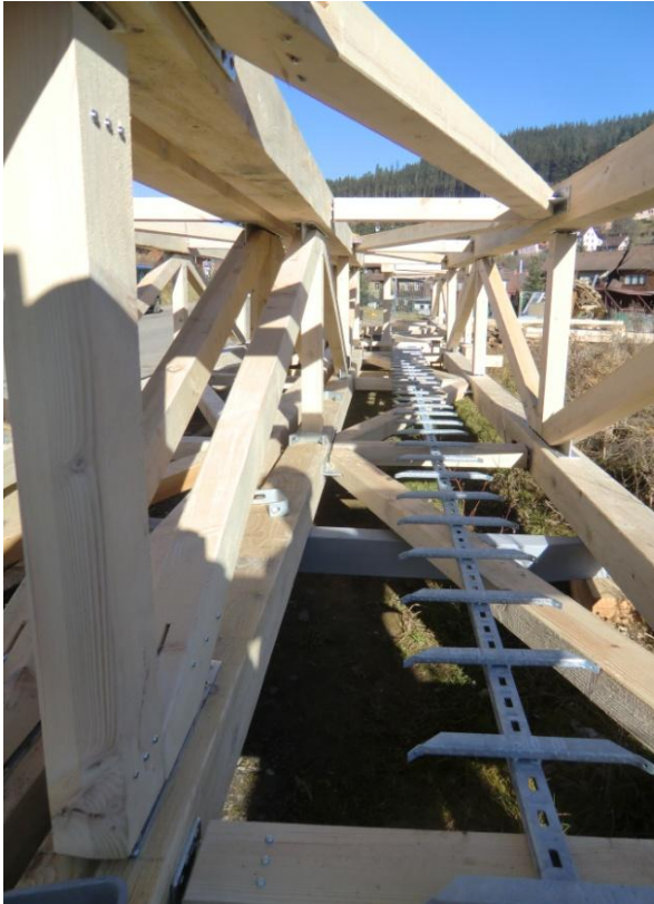
Abbildung 9: Integriertes Leitersystem
