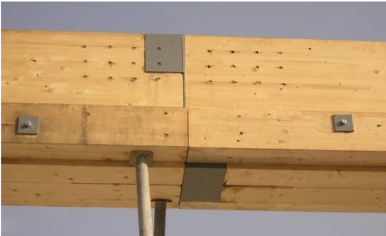
Abbildung 2: Stabdübelstoss mit Stahlblechkonsole des Mittenträgers
