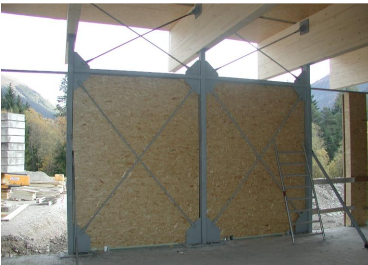
Abbildung 7: Ein Aussteifungselement in der Fassade
