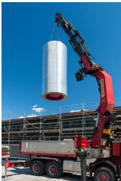
Abbildung 1: 25´000 l Pufferspeicher
