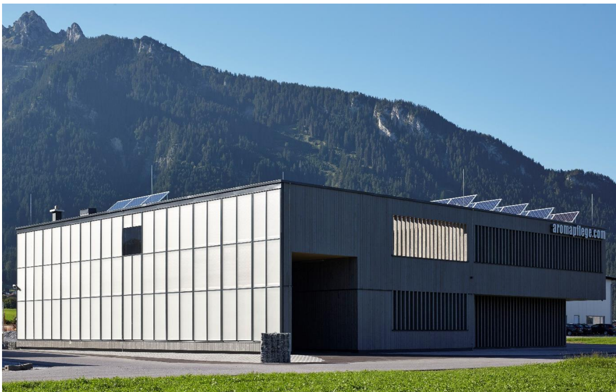
Abbildung 8: Aussenfoto Südseite mit Sonnenkollektoren
