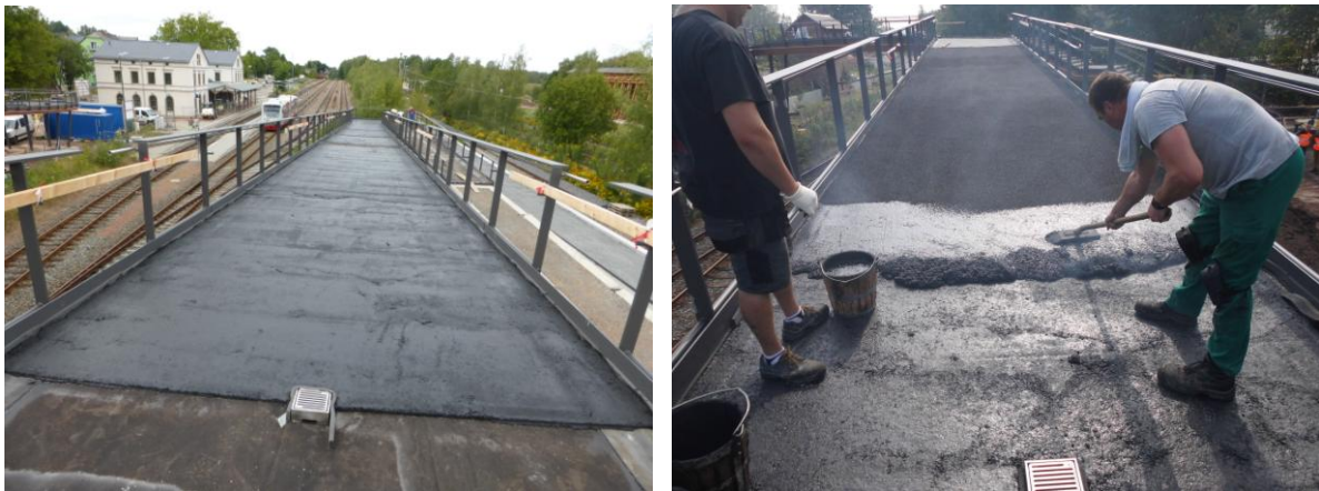
Abbildungen 36 und 37: Einbau Asphalt-Schutzschicht und Asphalt-Deckschicht mit Split-Abstreuerung. Quelle: S&L GmbH
