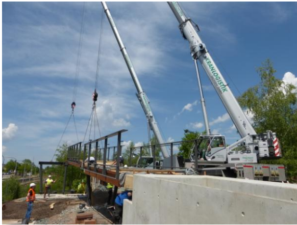
Abbildungen 19 und 20: Montagebeginn NB 01 und Fügen der BSH-Elemente an die Stoßträger. Quelle: S&L GmbH
