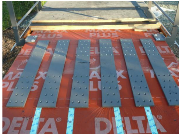
Abbildungen 21 und 22: Montageende NB 01 und Zuglaschen zur Verbindung der BSH-Elemente. Quelle: S&L GmbH
