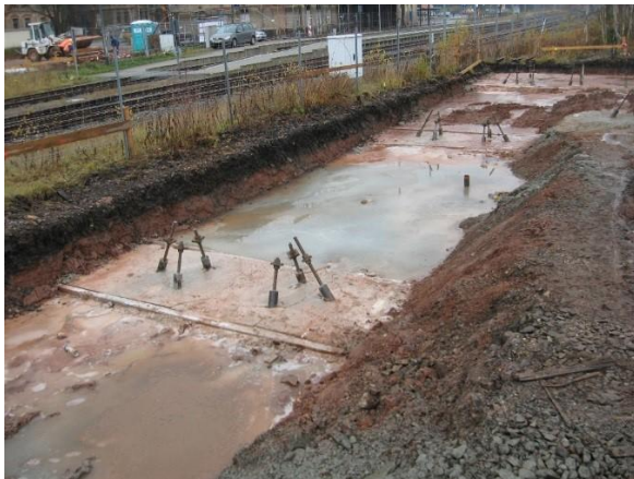
Abbildungen 2 und 3: Mikropfähle und Sauberkeitsschicht sowie Pfahlkopfbalken/-platten. Quelle: S&L GmbH
