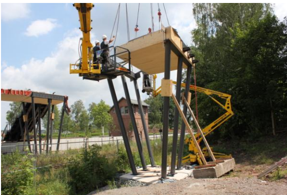
Abbildungen 25 und 26: Montage Stoßträger und HB-Element 1 und Lückenschluss zur Nebenbrücke 02. Quelle: S&L GmbH
