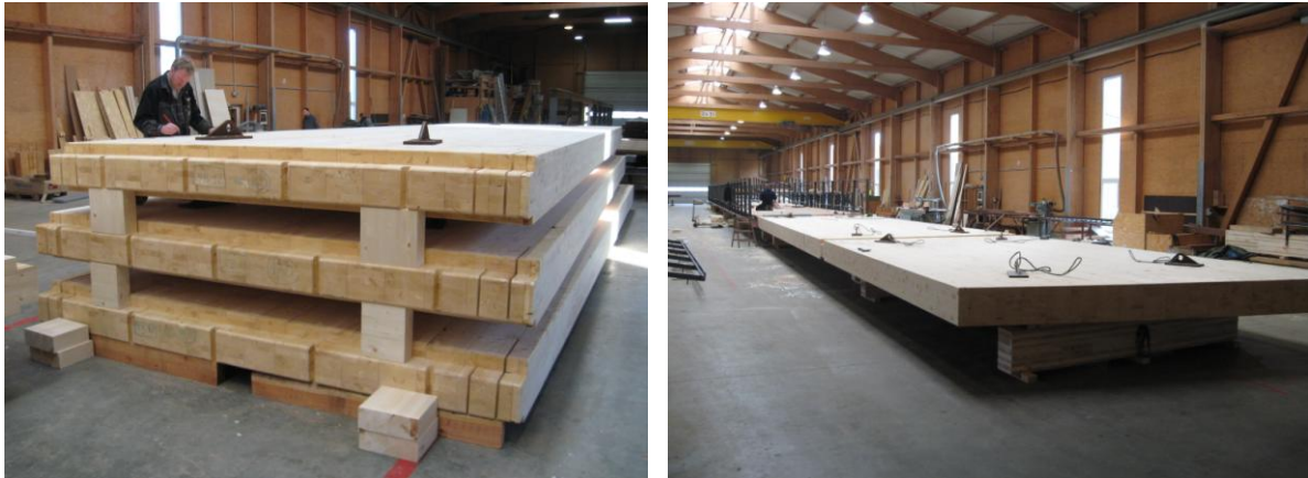
Abbildungen 11 und 12: Nebenbrückensegmente mit Abbund und ausgelegte Nebenbrücke 01. Quelle: S&L GmbH
