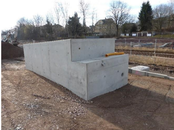
Abbildungen 4 und 5: Vorder- und Rückseite des ersten Drittels eines Widerlagers. Quelle: IBH mbH
