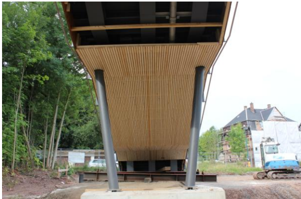
Abbildungen 31 und 32: beginnende Verschalung der Untersicht der Treppe 01 und Seitenansicht mit 3-S-Platten. Quelle: S&L GmbH
