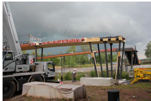
Abbildungen 25 und 26: Montage Stoßträger und HB-Element 1 und Lückenschluss zur Nebenbrücke 02. Quelle: S&L GmbH
