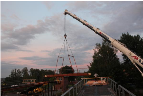
Abbildungen 27 und 28: Einheben des Mittelteils und passgenaues Platzieren auf den Stoßträgern. Quelle: S&L GmbH
