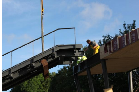
Abbildungen 29 und 30: Einheben der Treppe 02 und Verbindung mit oberem Kopfplattenstoß. Quelle: S&L GmbH
