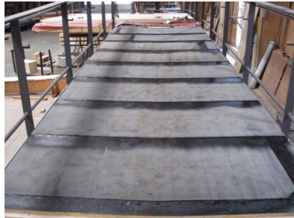
Abbildungen 17 und 18: Kerto-Q mit Entlüftungsbohrungen und werksseitig hergestellte Abdichtung. Quelle: S&L GmbH
