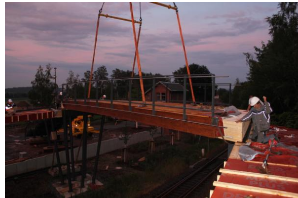
Abbildungen 27 und 28: Einheben des Mittelteils und passgenaues Platzieren auf den Stoßträgern. Quelle: S&L GmbH
