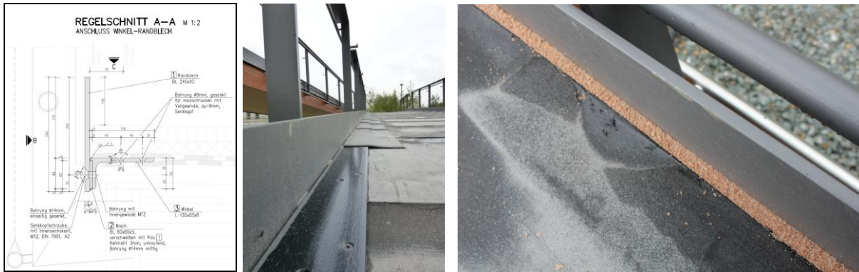
Abbildungen 33 bis 35: Planung und Ausführung Randwinkel mit Abdichtung und wasserdurchlässiger Fuge. Quelle: S&L GmbH
