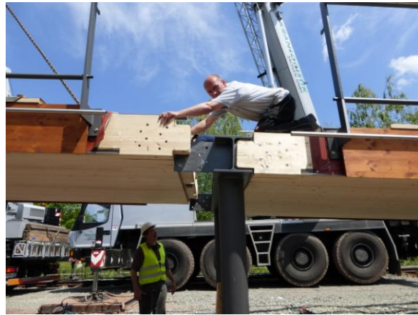
Abbildungen 19 und 20: Montagebeginn NB 01 und Fügen der BSH-Elemente an die Stoßträger. Quelle: S&L GmbH
