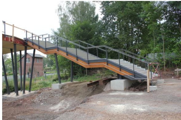
Abbildungen 31 und 32: beginnende Verschalung der Untersicht der Treppe 01 und Seitenansicht mit 3-S-Platten. Quelle: S&L GmbH
