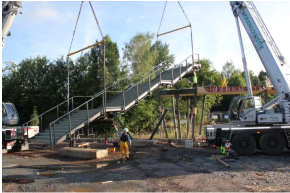
Abbildungen 29 und 30: Einheben der Treppe 02 und Verbindung mit oberem Kopfplattenstoß. Quelle: S&L GmbH
