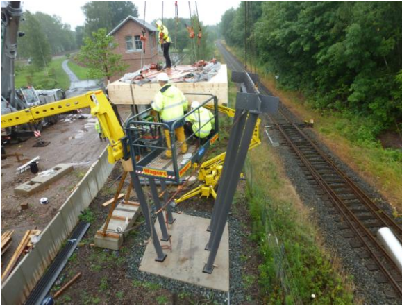
Abbildungen 23 und 24: Montage Stoßträger und HB-Element 3 und Lückenschluss zur Nebenbrücke 01. Quelle: S&L GmbH
