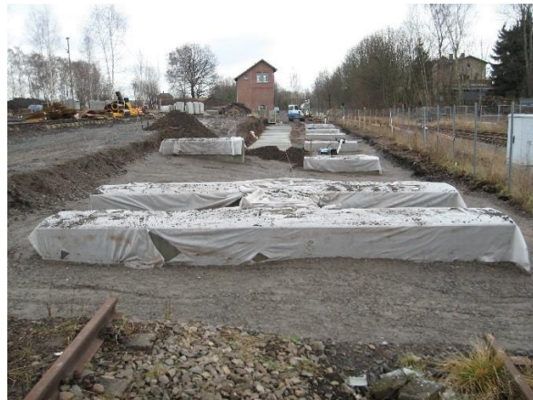
Abbildungen 2 und 3: Mikropfähle und Sauberkeitsschicht sowie Pfahlkopfbalken/-platten. Quelle: S&L GmbH
