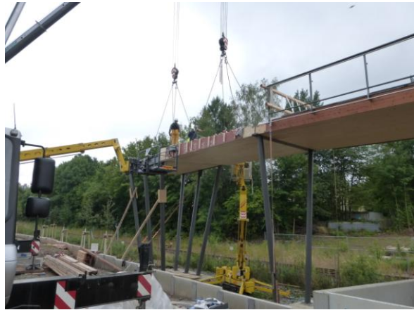
Abbildungen 23 und 24: Montage Stoßträger und HB-Element 3 und Lückenschluss zur Nebenbrücke 01. Quelle: S&L GmbH
