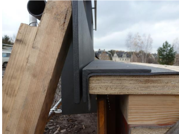
Abbildungen 15 und 16: Ausschnitt Werkplanung mit Detailpunkt Randwinkel und Einbausituation am Muster. Quelle: IBH mbH
