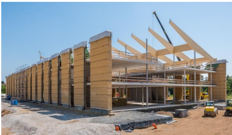
Abbildung 14: Bauzustand Lehmfassade und Holztragwerk
