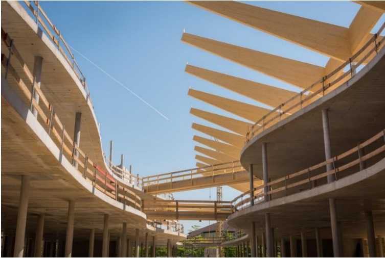
Abbildung 15: Bauzustand Atrium und Holztragwerk
