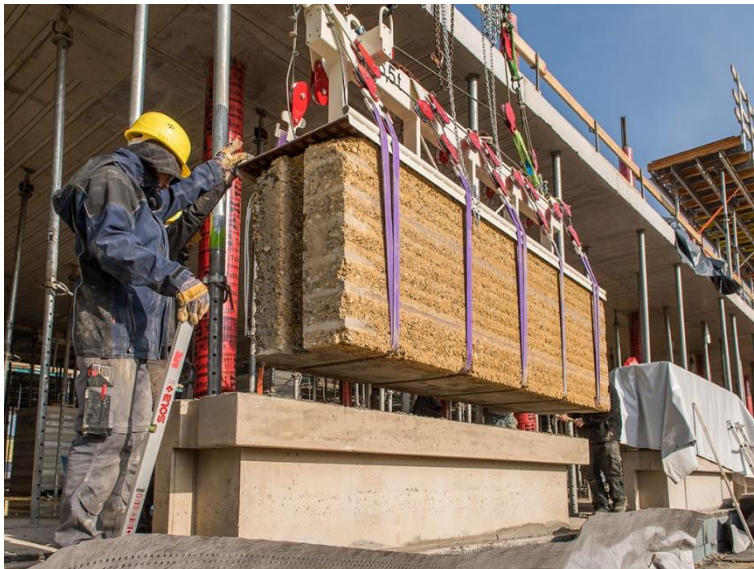
Abbildung 13: Einbau der vorgefertigten Lehmfassadenelemente
