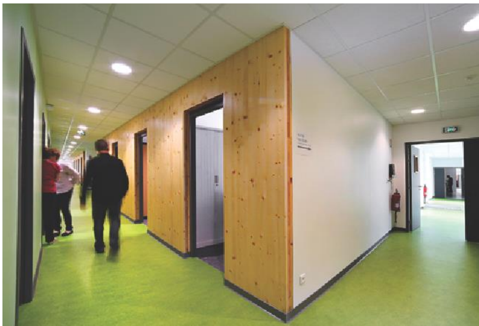
Illustration 3 : CLT apparent dans les couloirs du bâtiment
