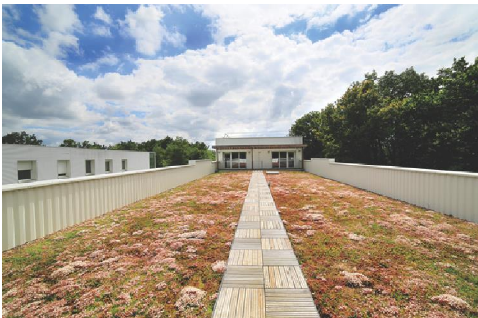
Illustration 5 : Toiture végétalisée du R+1
