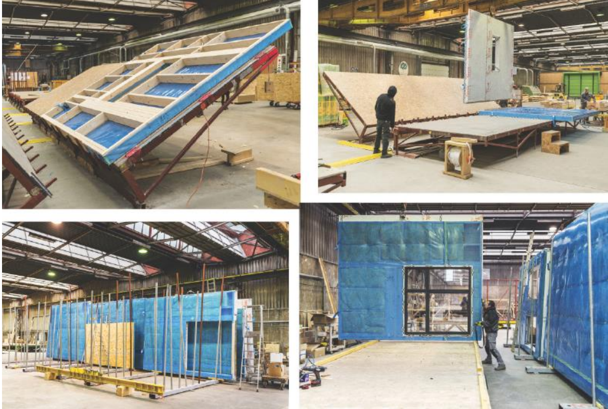
Illustration 2 : fabrication des murs à ossature bois dans notre site de production à Chevilly (45).
