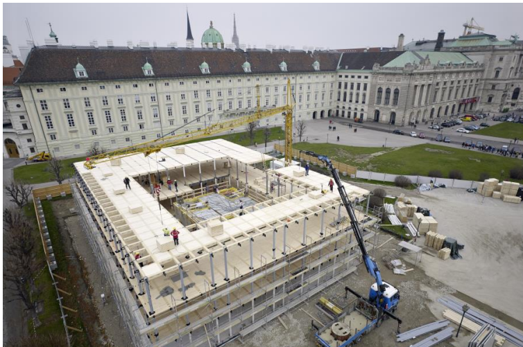
Abbildung 6: Bauablauf Tragwerk und Decke
