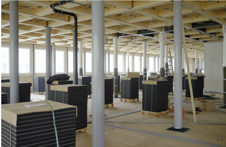
Abbildung 7: Bauablauf Innenausbau Doppelboden
