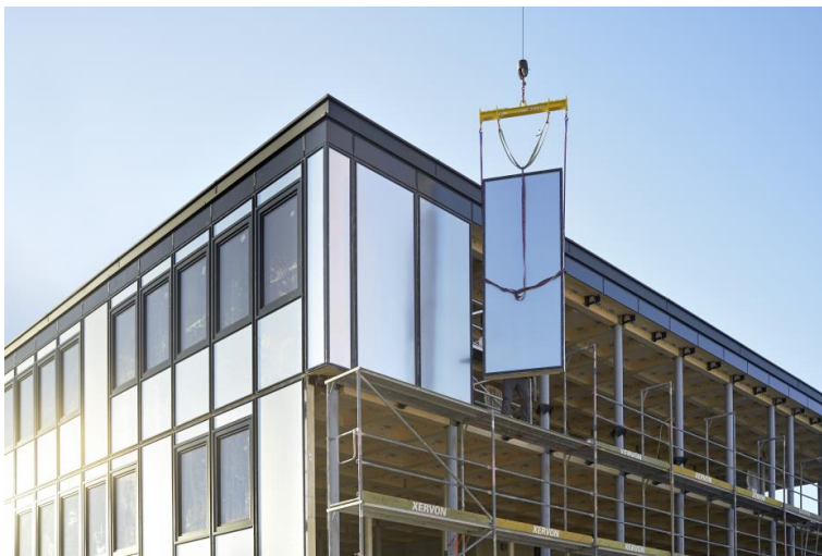
Abbildung 8: Bauablauf Errichtung Fassade
