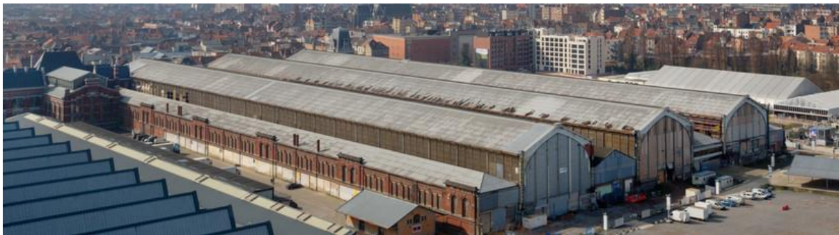
Abbildung 1: Ehemaliger Güterbahnhof Gare Maritime (Quelle: Extensa Group)
