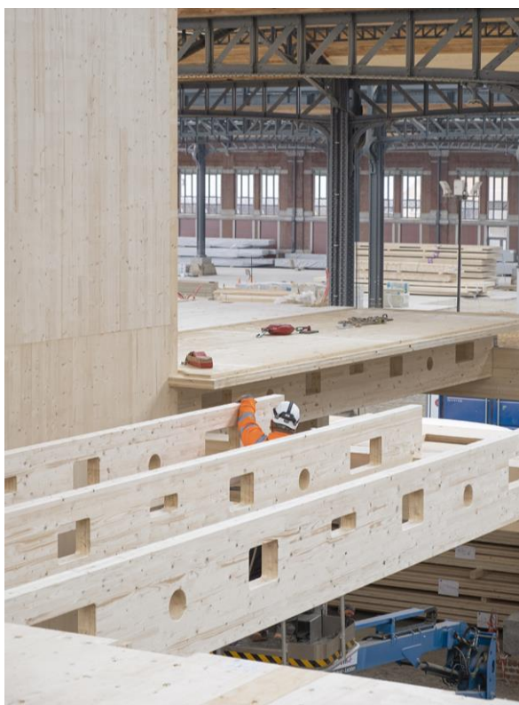
Abbildung 8: Montage BSH-Rippen (Quelle: ZÜBLIN Timber)
