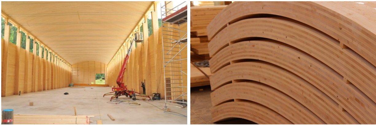
Abbildung 1: Produktionshalle der Firma Unterraine und gekrümmte BSP-Elemente
