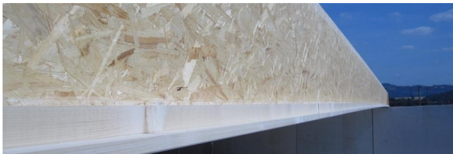
Bild 14: Zeigt ein überhöhtes Kielstegelement im eingebauten Zustand.
