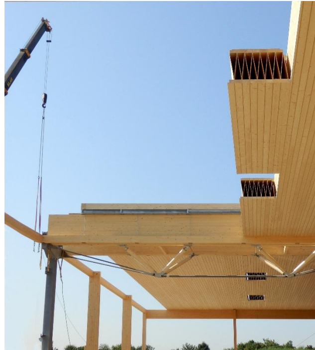
Abbildung 3 und 4: Dargestellt ist die Montage der 21,5 m langen Einfeldenelemente eines Hallendaches mit einer Bauhöhe von 73 cm. Das Eigengewicht eines Elements beträgt 2,7 t.
