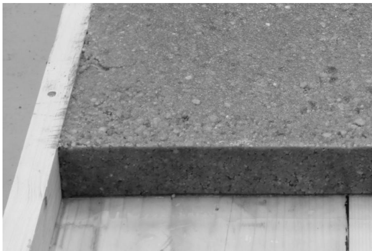
Abbildung 2: Druckzonenverstärkung mit Polymerbeton
