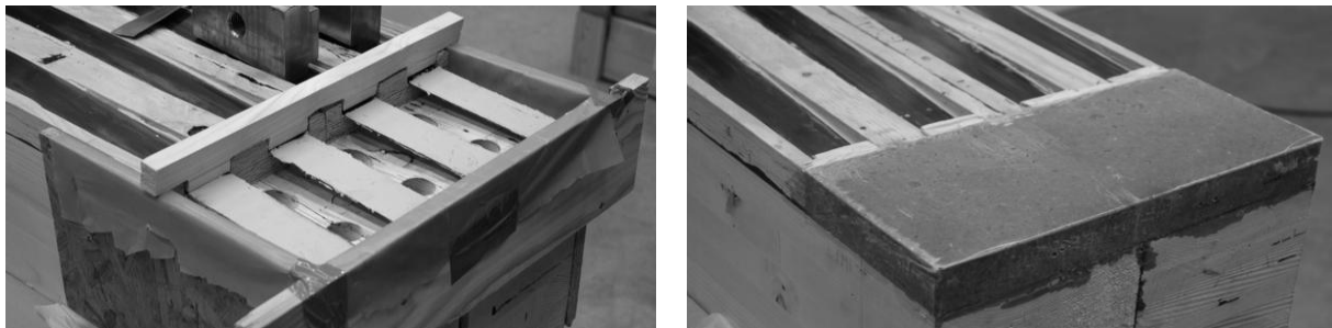
Abbildung 8: Herstellung des Endauflagers am Beispiel des Prototyps HTB-1
