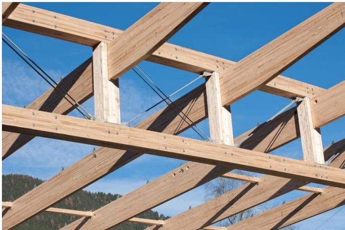
Abbildung 15: Pilotprojekt BIRKE|BSH: Lagerhalle der NORITEC Holzindustrie GmbH in Stall im Mölltal, Fachwerkkonstruktion.
