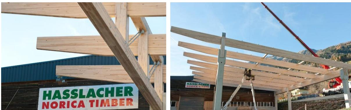
Abbildung 16: Pilotprojekt BIRKE|BSH: Hauptträger mit einer Auskrägung von 5,75 m und einer Spannweite von 18 m. Der Träger rechts wurde als Verbundbauteil ausgeführt.
