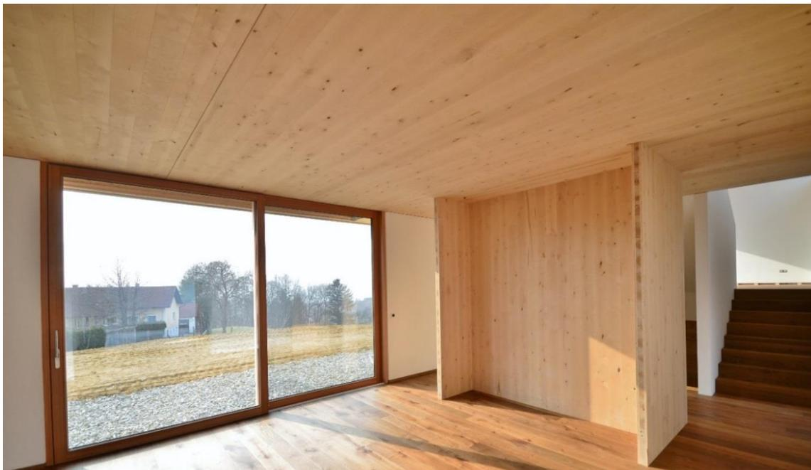
Abbildung 14: Wände und Decken aus BIRKE|BSP des Pilotprojektes Einfamilienhaus Raser mit der Exzellentoberfläche [Quelle: Holz&Bau Hirschböck Hartberg/Österreich].
