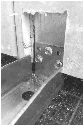
Bild 11: Anker Überstand
