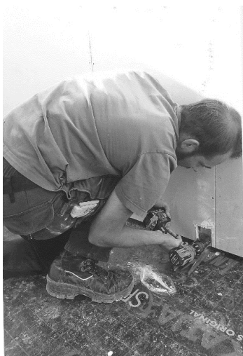
Bild 10: Anker Anschrauben Fotos: Bau Fritz
