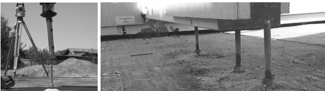
Abbildung 8: Wandgrundlinie mit Höhenmutter justieren und Wand aufsetzen Foto: Bau Fritz
