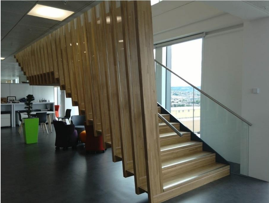
Abbildung 5: Treppe bei ARUP aus BSH Eiche, Résix eingeklebte Gewindestangen verbinden Geländer und Setzstufen biegesteif.
