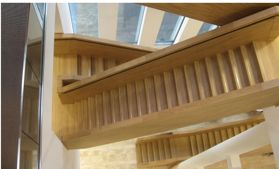
Abbildung 6: Treppe in den Niederlanden, Wange und Geländer aus 1.4m hohen Eichen BSH.
