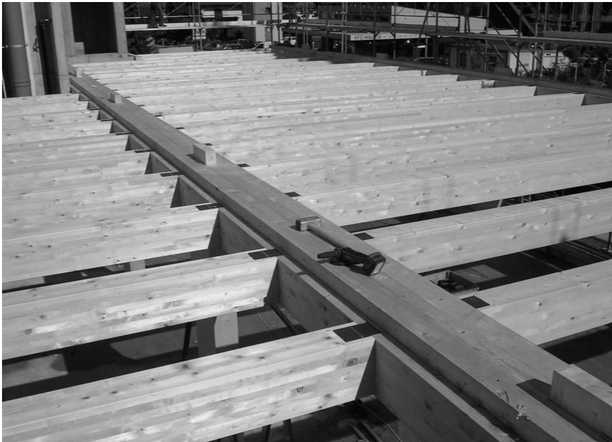
Abbildung 9: BSH-Balkenrost
