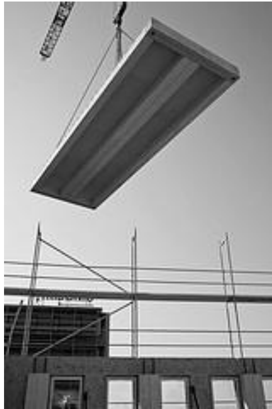
Abbildung 5: Deckenmontage
