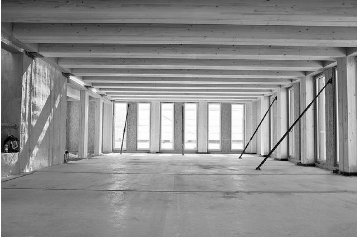
Abbildung 17: Ausbaufertiger Innenraum (1 Tag nach der Montage)
