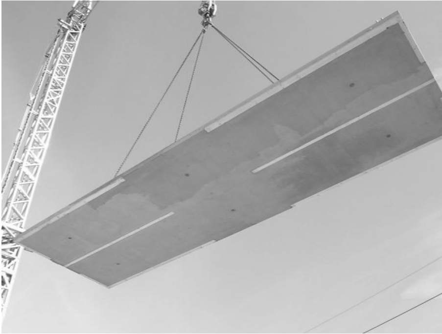
Abbildung 10: Stahlbeton-Fertigteilplatte
