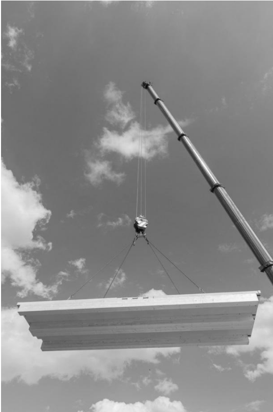
Abbildung 13: Hybriddecke ohne Randbalken
