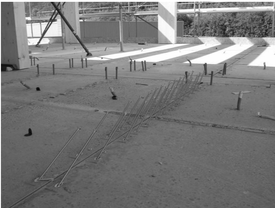
Abbildung 11: Nachträglicher Schraubverbund
