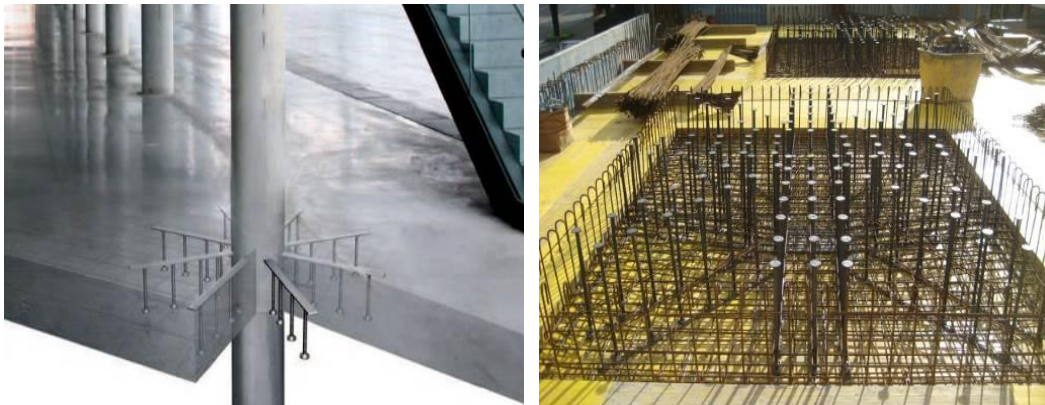
Abbildung 3: Durchstanzverstärkungen im Betonbau
