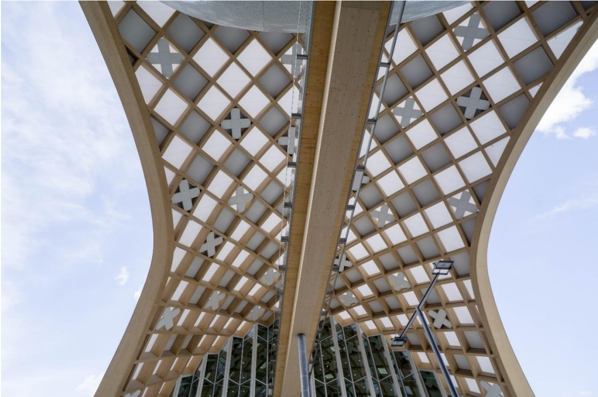
Abbildung 15: Blick von unten in das Dach über der Strasse. Die «Schweizerkreuze» sind nicht nur Ornament sondern wirken im Innenraum auch als Akustik-Paneele.
