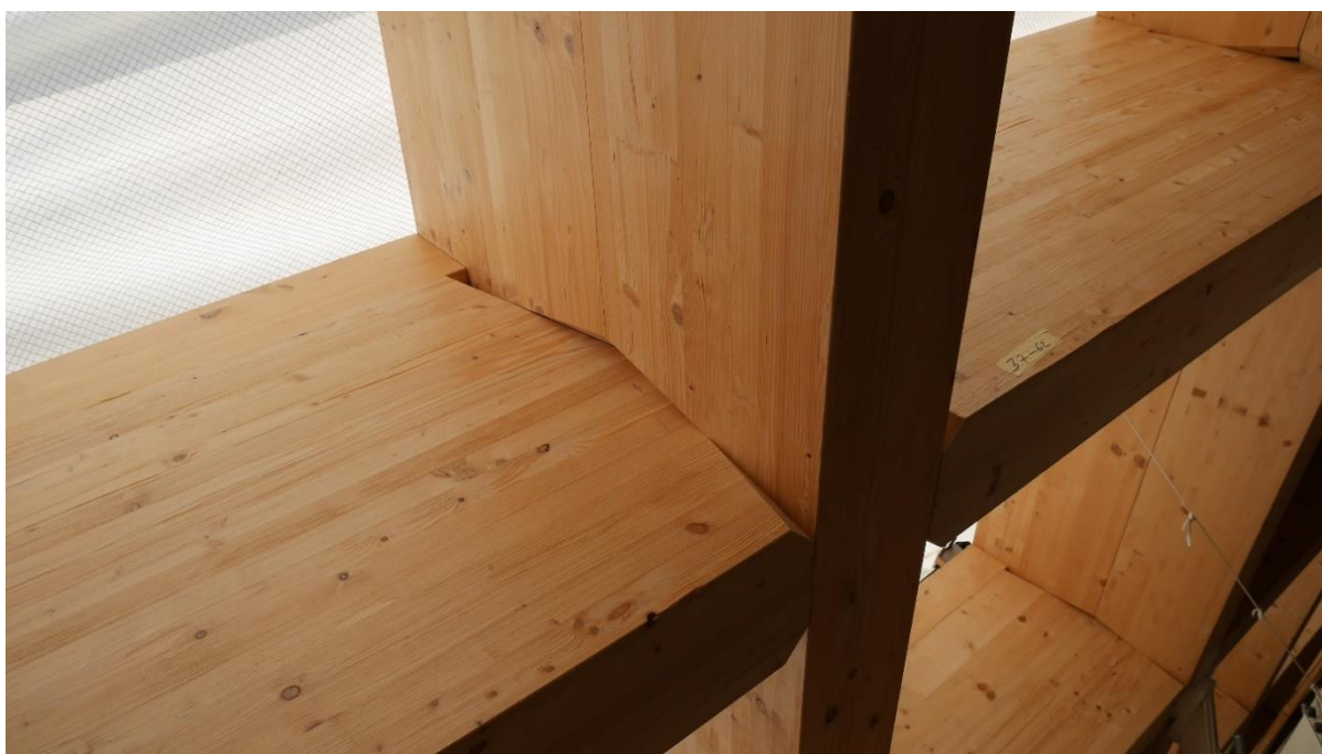
Abbildung 6: Fertig montierte «SkewLap» Kreuzungen. Die doppelt hohen Träger (horizontal in diesem Bild) werden zur Aussenseite hin durch ein Füllstück ergänzt, welches nur von Knoten zu Knoten spannt und eine geschlossene Fläche zwischen Gitterschale und Fassade herstellt.
