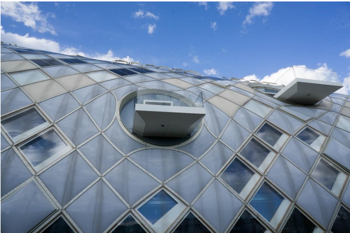
Abbildung 16: Vier der neun Elementtypen (ETFE, Glas, Opak, PV, öffentbare ETFE) und die Balkone in der Fassade.
