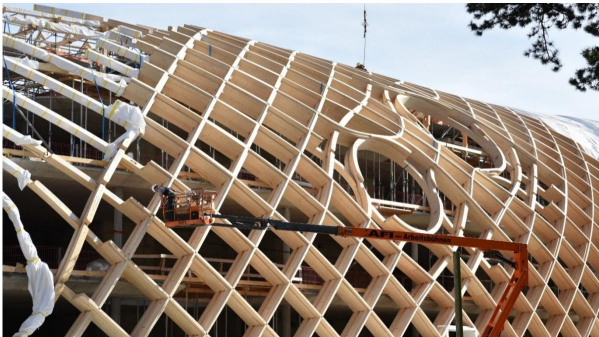
Abbildung 13: Gitterschale während der Installation (Mai 2017)
