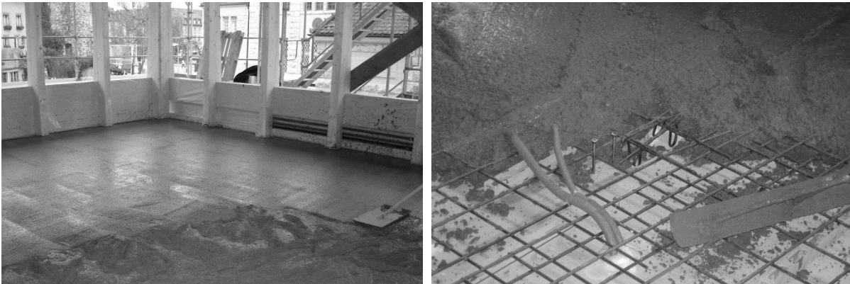
Abbildung 5: Einbringen von Ortbeton
