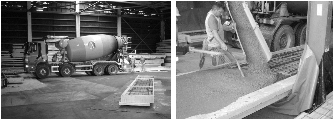
Abbildung 2: Herstellung von HBV-Decken
