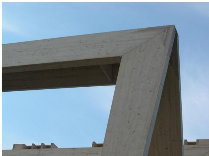
Abbildung 1: Rahmenecken mit Eschenverstärkung im Bereich des Zuganschlusses
