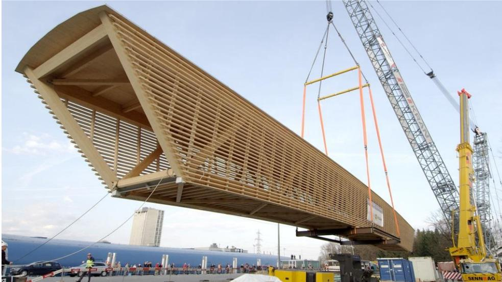
Abbildung 16: Montage Neumattbrücke
