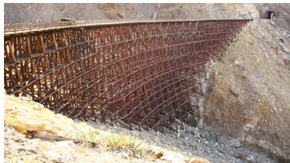
Abbildung 2: Ansicht der 1932 erbauten Goat Canyon-Jochbrücke in Kalifornien mit 180 m Länge und 61 m Höhe
