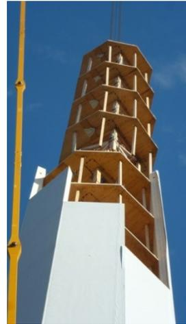
Abbildung 4: Timber Tower Holzturm mit 100 m Höhe in Hannover-Marienwerder, während der Bauphase (2012)
