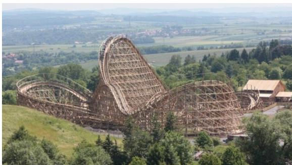
Abbildung 1: Ansicht der 2007/2008 aus nicht keilgezinktem kesseldruckimprägniertem Kiefernholz errichteten Holzachterbahn «Mammut» im Freizeitpark Tripsdrill
