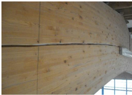
Abbildung 9: Quersugschäden Satteldachträger
