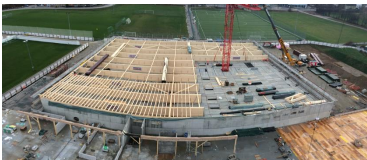
Abbildung 4: Montage der Träger
