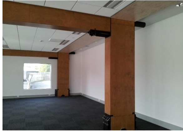
b) Die Bewehrung an den Rahmenknoten und Stützenfüßen wurde in Sicht gelassen
