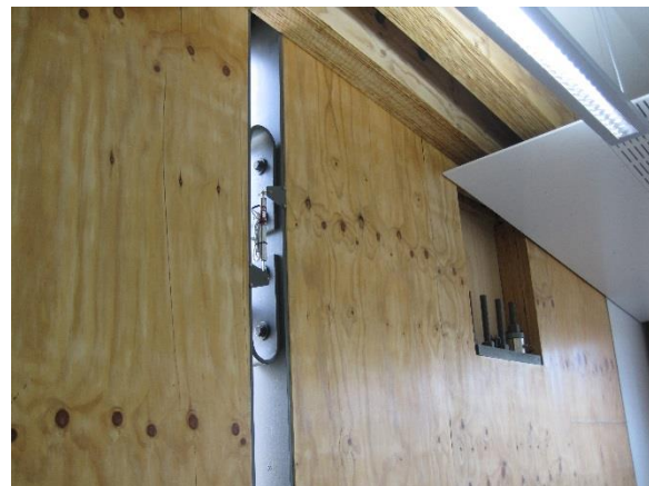
b) Mit UFP-Bewehrung gekoppelte Wände; rechts ist die Verankerung des Spannstahls sichtbar
