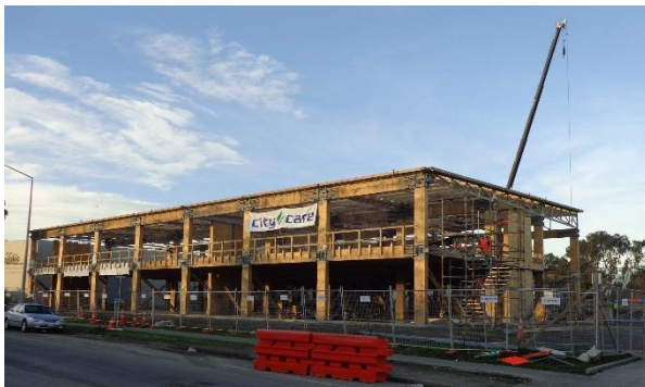
a) Skelett aus vorgespannten Wänden und Rahmen
