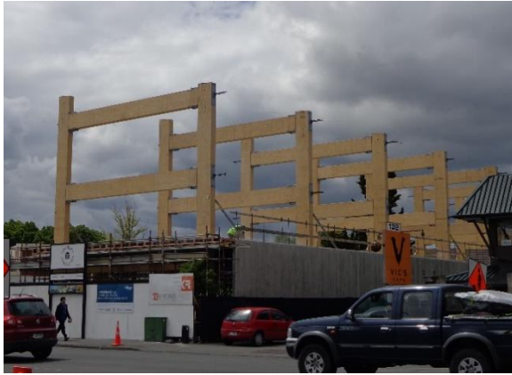
a) Dreigeschossiger Rahmenaufbau
