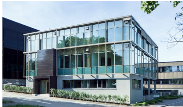
b) Fertiges Gebäude
