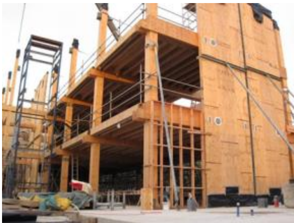
a) Die Struktur in der Bauphase
