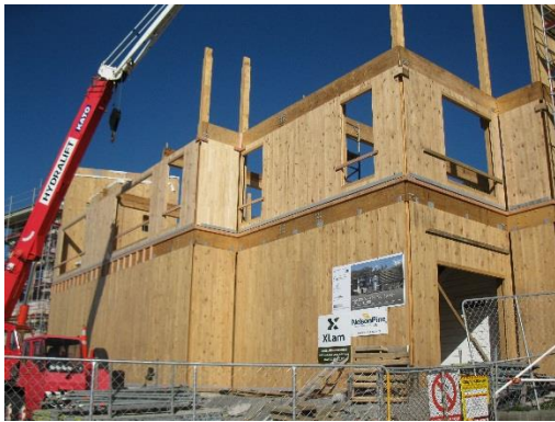
a) Installation der Brettsperrholzwände
