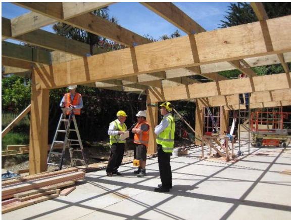
a) Rahmenkonstruktionen mit Dachpfetten
