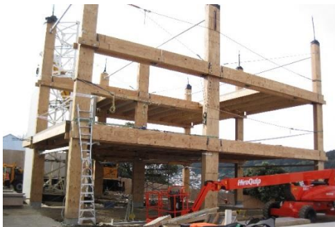
a) Dreigeschossiger Rahmenaufbau im Bauzustand
