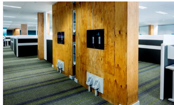
b) Gekoppelte Wände mit sichtbarer Bewehrung und Verbindungsmuffen der Spannstäbe
