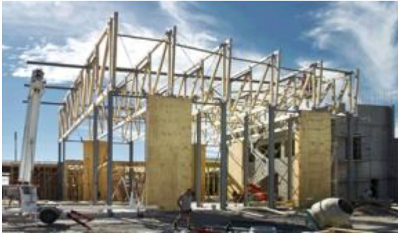
a) Die Holzfachwerke der Konstruktion werden von den Holzwänden und Stahlstützen getragen
