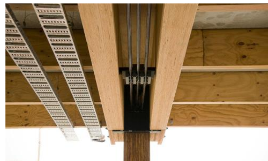
b) Vorgespannter Holzträger mit externem Spann Stahl mit Umlenkblock
