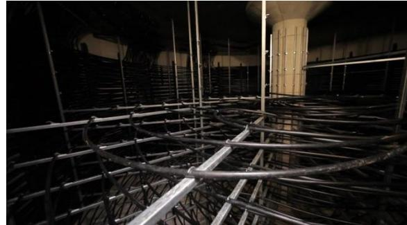
Abbildungen 7: Eisspeicher, ohne und mit Installation
