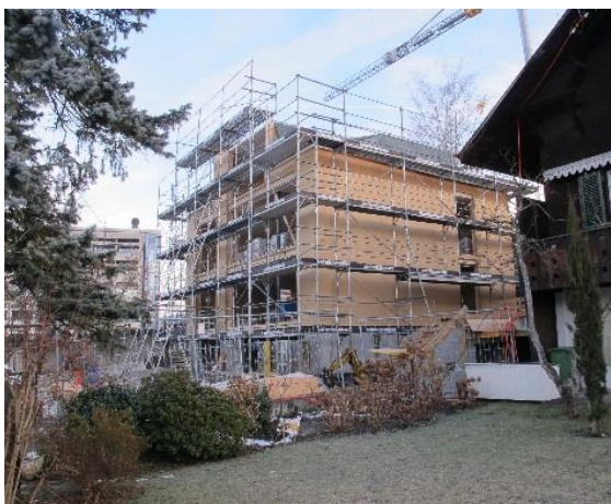
Abbildung 26: Baustelle eines mehrgeschossigen Wohnhauses in Thun, Schweiz
