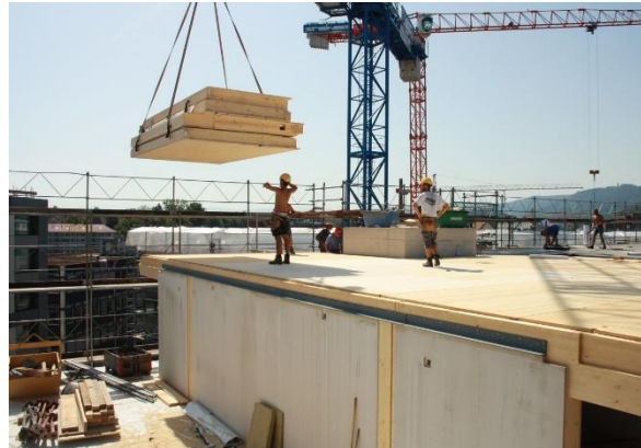
Montage vorfabr. Elemente Pile up Giesshübel, 2013 (Quelle: burkhalter sumi architekten )
