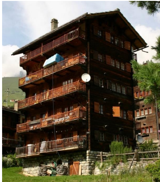
Holzhochhaus in Evolène, 12Jhdt (Quelle: Lignum )
