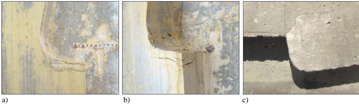
Abbildung 11: Vollquerschnitt (Serie B1): Bruchbilder der Biegeprüfungen: a), b) Stirnholzpressung im Holz und c) Risse in der Schubkonsole des Betons
