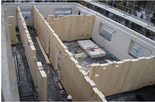
Abbildung 10: Innenwände aus verleimtem Massivholz
