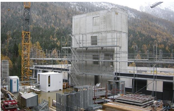
Abbildung 8: Treppenkerne aus Ortsbeton
