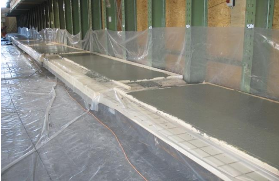
Abbildung 6: Vorfabrikation im Werk
