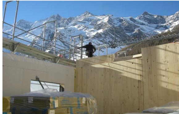
Abbildung 7: Montage vor Ort
