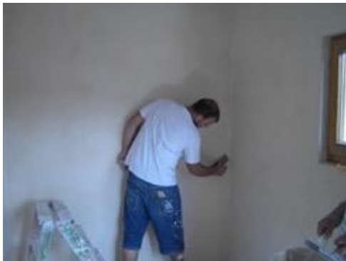
Abbildung 2: IQUH, Innenbekleidung mit Lehmbauplatten und Kalkputz
