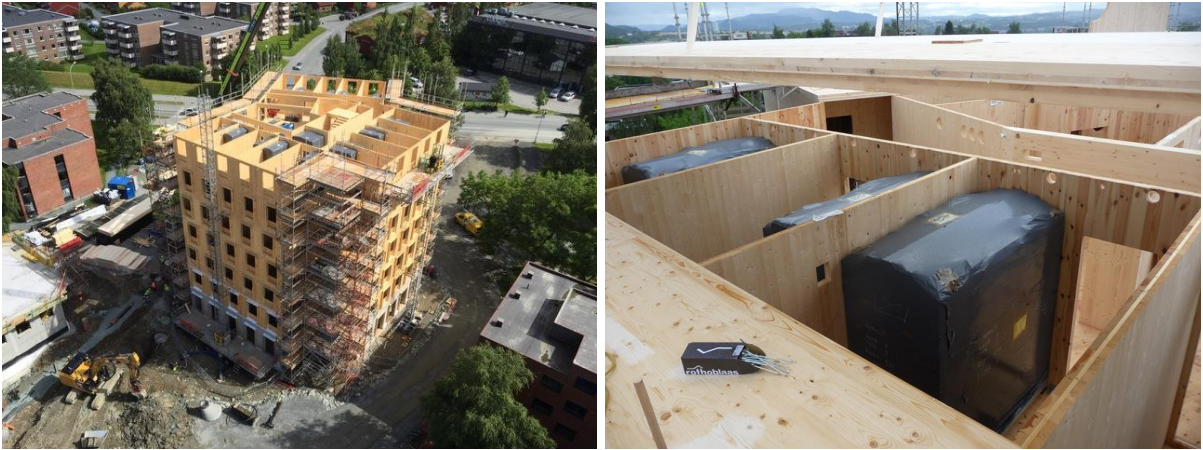
Abbildung 10: Bauphase erster Wohnblock; Nasszellen vorgefertigt [Woodcon AS]
