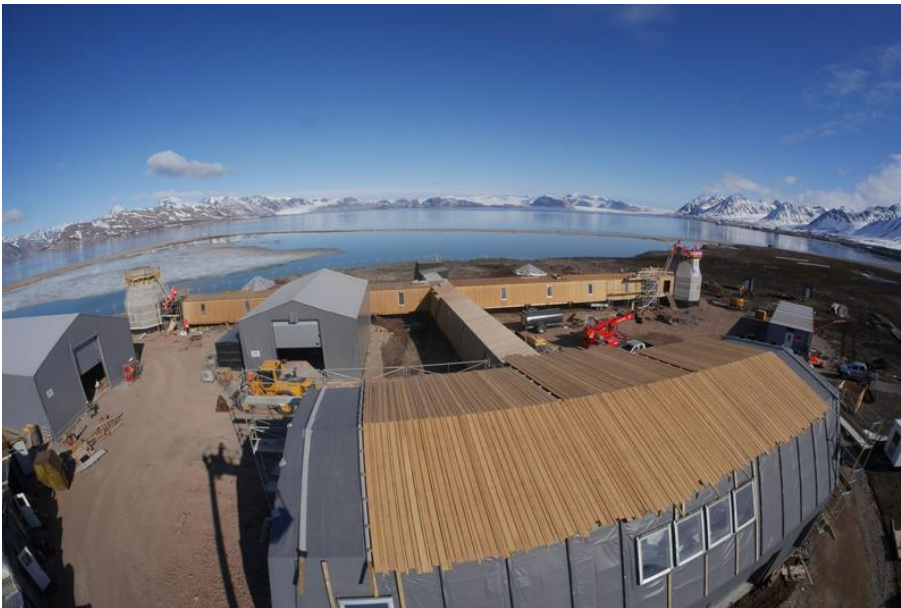
Abbildung 3: Radarstation in Spitzbergen (NOR) – hier sieht man die zwei Radarsockel die durch einen Kreuzgang aus CLT verbunden sind [Veidekke Arctic]
