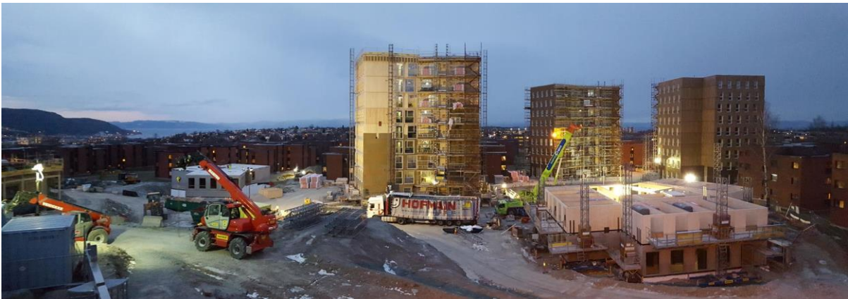
Abbildung 12: Montagebeginn des vierten Wohnblocks [Woodcon AS]
