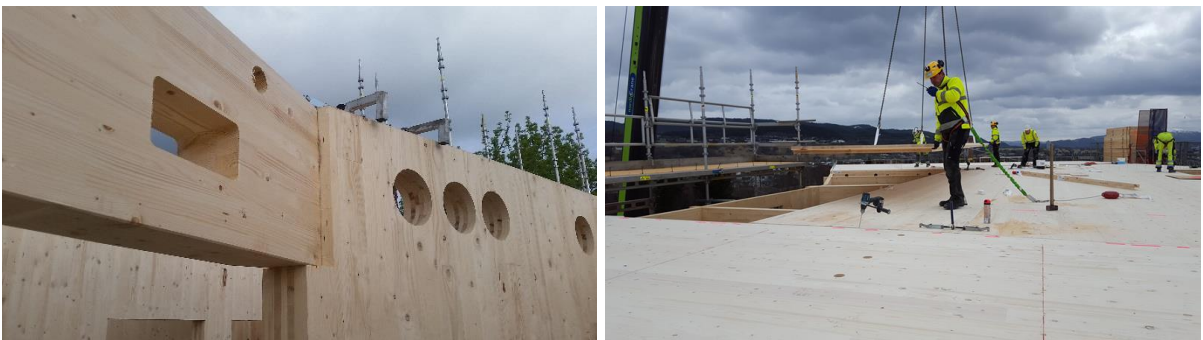
Abbildung 11: Anschluss BSH mit CLT mit Leitungsdurchführungen; Deckenmontage [Woodcon AS]
