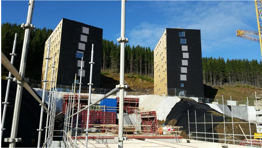
Abbildung 4: Zwei fertiggestellte Studentenwohnhäuser (insg. 8 bzw. 10 Geschosse) in Tromsø (NOR) [Woodcon AS]
