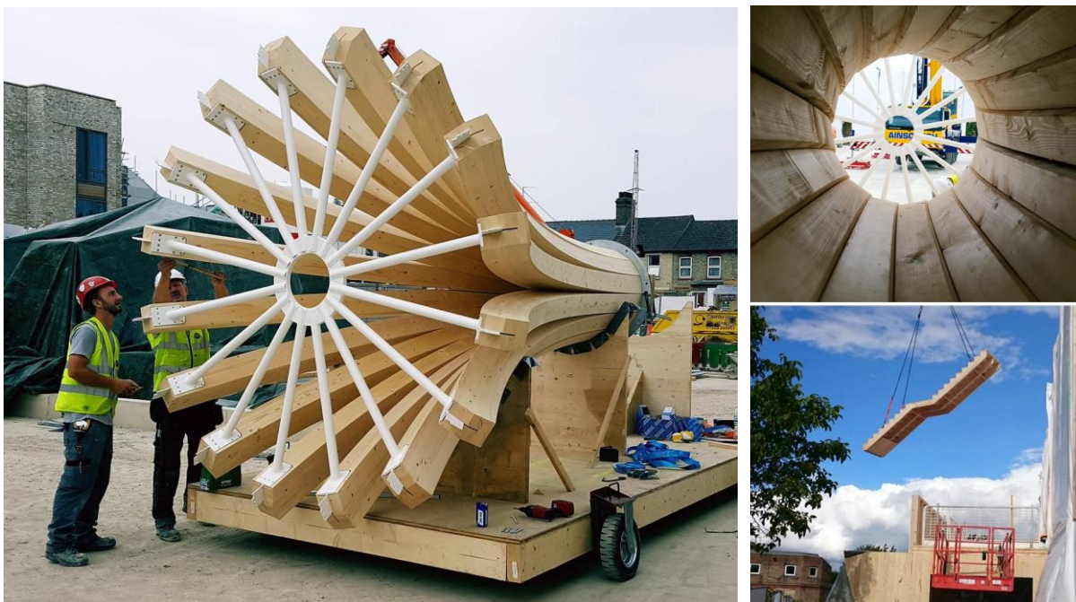
Abbildung 10: Transport Baumstruktur, Treppenanlage
