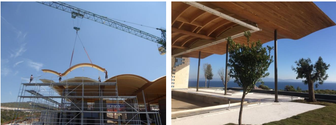
Abbildung 13: Montage der freigeformten Dachrandträger
