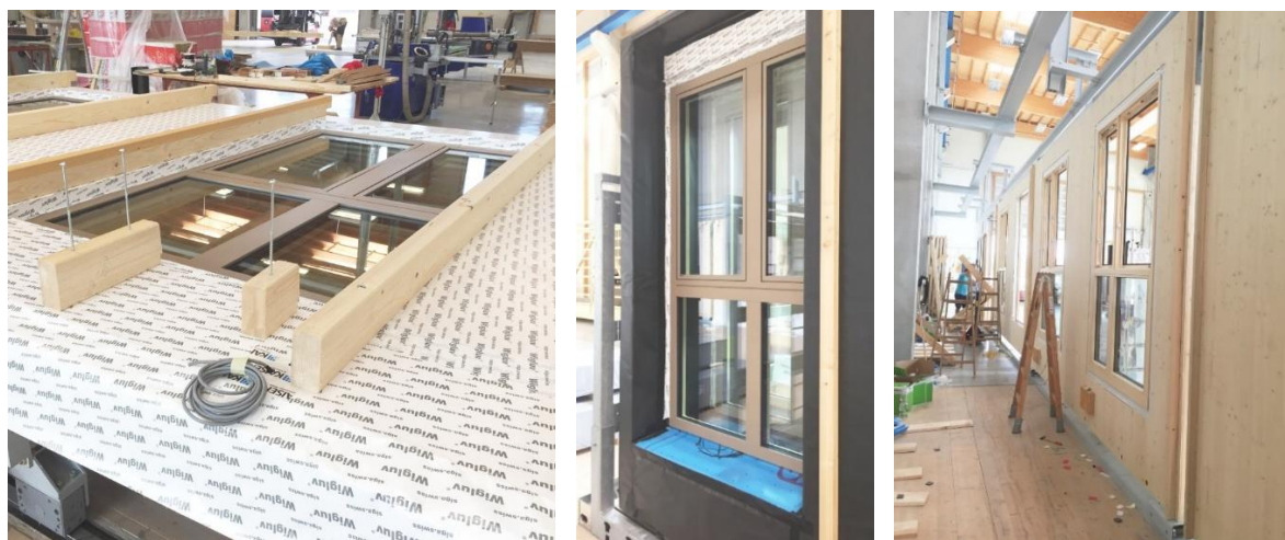
Abbildung 12: Vorfertigung der BSP-Wände
