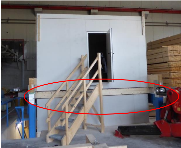
Abbildung 2: Außenansicht des Bauakustik-Prüfstands der best wood SCHNEIDER® GmbH, Eberhardzell.
