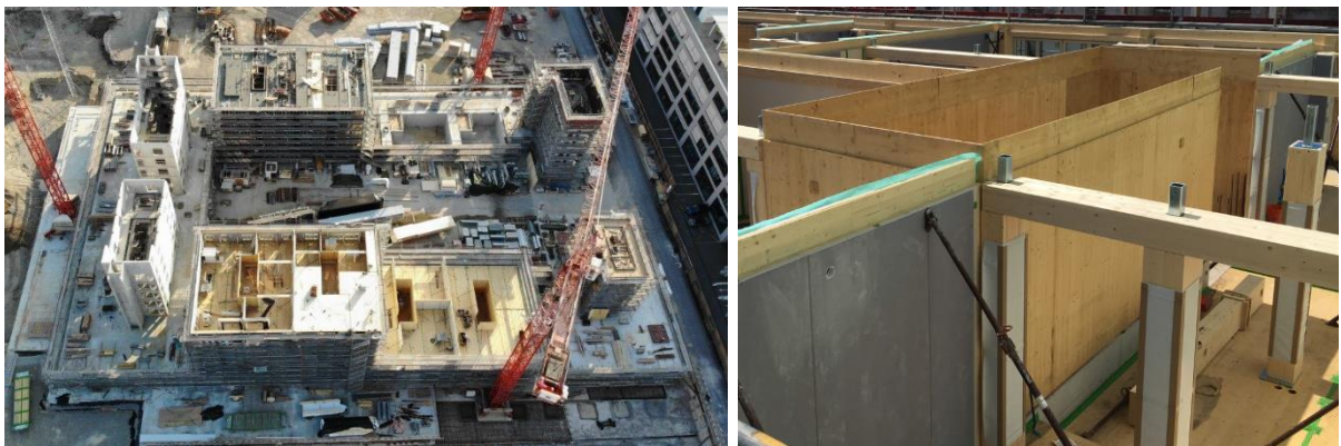
Abbildung 8 und 9: Luftbild der Holzbaumontage vom 05.07.2019. Gut sichtbar der vormontierte Holzbau um die Treppenhäuser.
