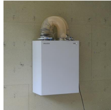
Abbildung 6: Lüftungsgerät MAICO WS170KL
