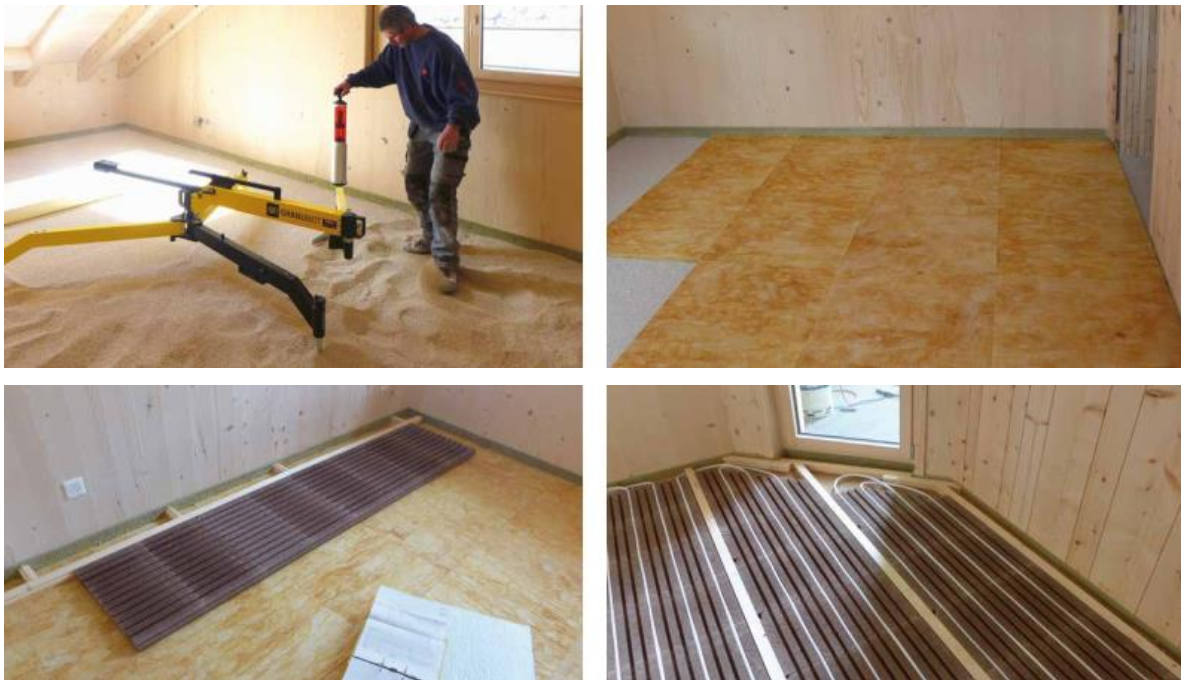
Abbildung 12: Praxisbeispiel MFH in Engelberg; Montierte MF-Stellstreifen, Einbringen und Nivellieren mit «Granubot» (Abbildung links-oben); verlegen von Trittschalldämmung (Abbildung oben-rechts); Verlegen von Lithotherm-Randelementen+Randlatte (Abbildung unten-rechts); Verlegen weiterer Estrich und Fussbodenheizungsrohre (Abbildung unten-rechts) [10]
