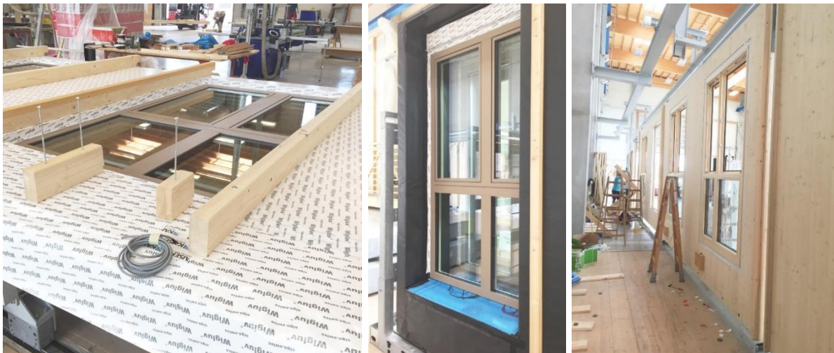
Bild 10: Vorfertigung der BSP-Wände
