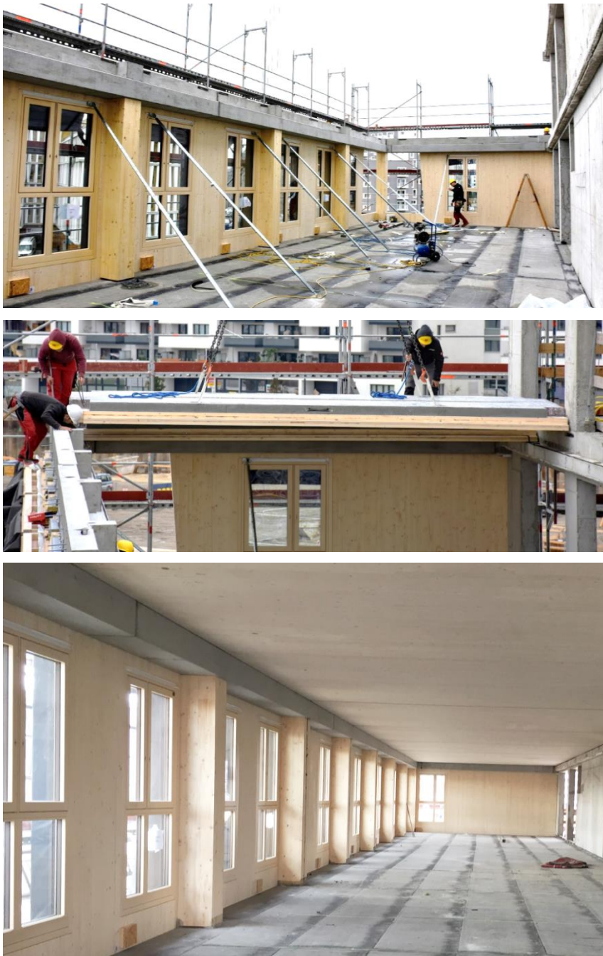
Bild 11: Ausführungsfotos Holzbaumontage im HoHo Next
