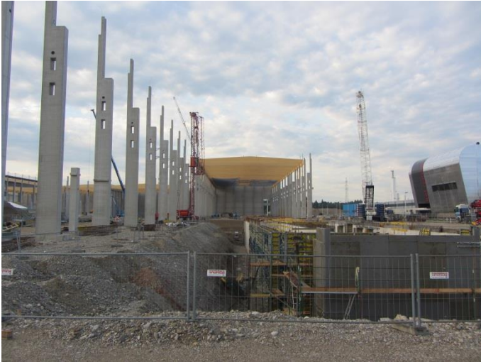
Abbildung 10: Baugruben und Keller im Montagebereich
