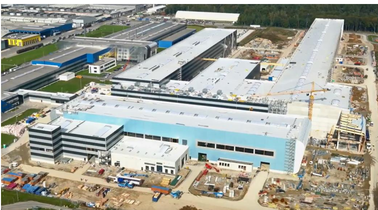
Abbildung 16: Stand Baustelle Mitte Oktober
