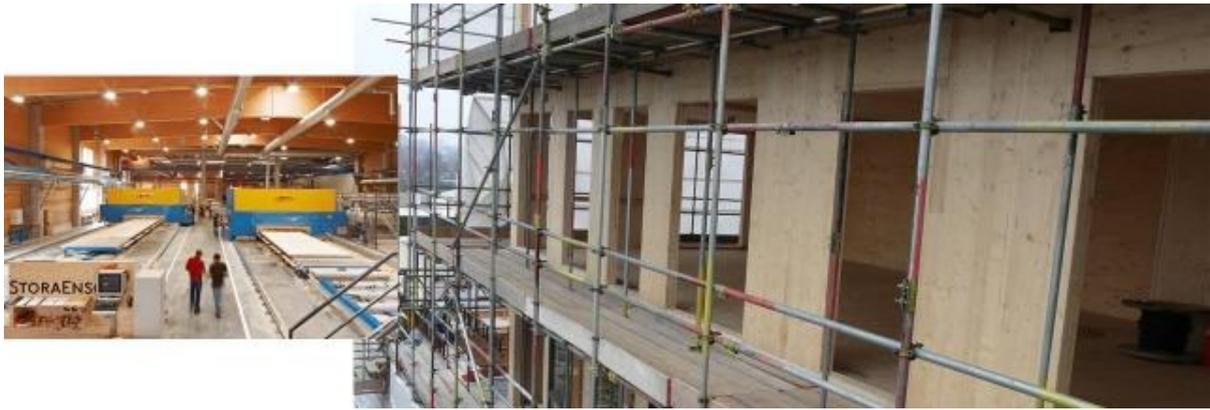
Abbildung 12: Brettsperrholzbauten werden in den meisten Fällen wie herkömmliche Ziegelsteinbauten auf der Baustelle montiert. Die Ausbauarbeiten mit Dämmungen, Dichtungen, Platten und Verkleidungen usw. erfolgen unter Baustellenbedingungen auf der Baustelle.
