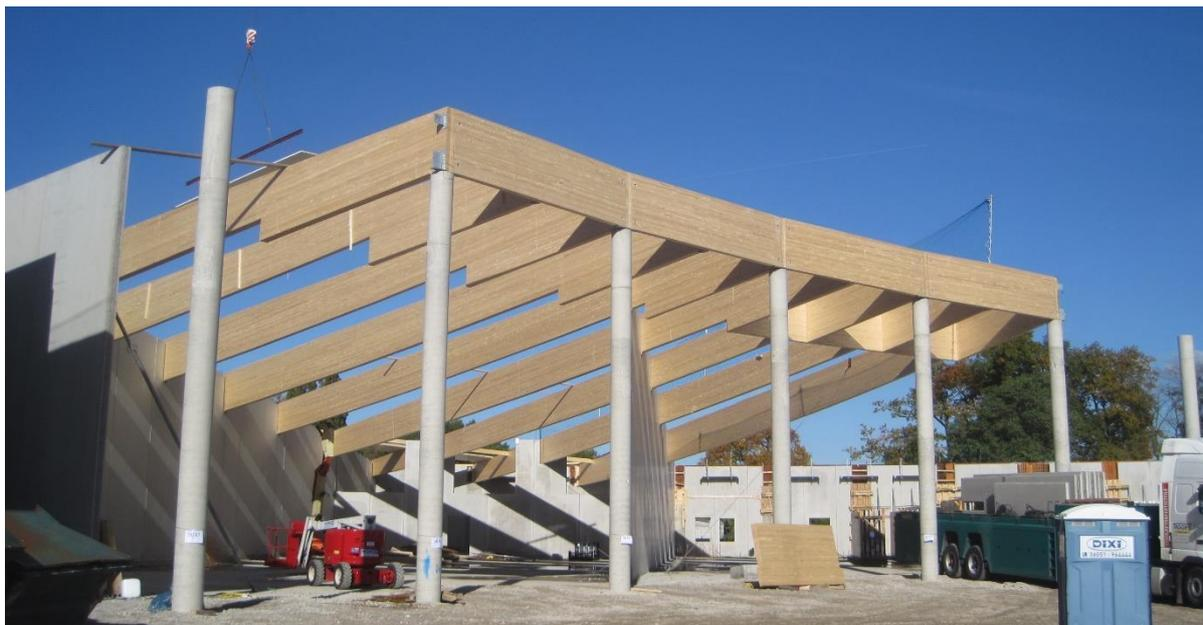
Abbildung 10: Die elliptische Form des NVZ ergibt für jeden Binder einen anderen Winkel zu festen und verschiebbaren Auflagern.
