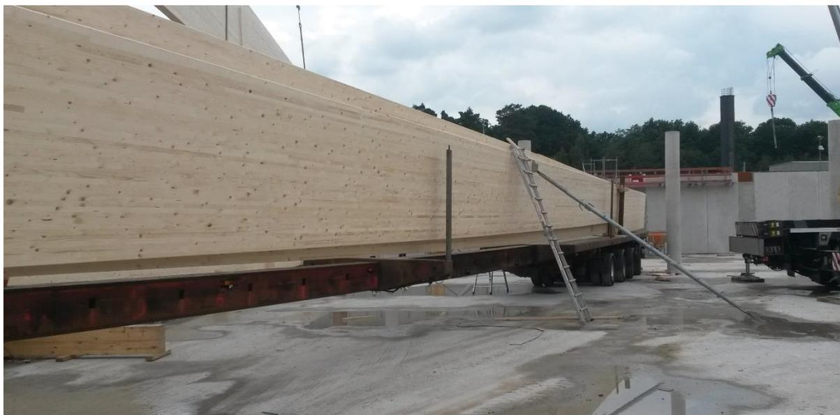
Abbildung 9: Der Transport der unterschiedlich langen und hohen Binder erfolgt über 450 km.
