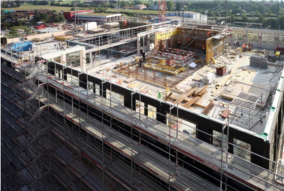
Abbildung 14: Die Montage erfolgte im Zweiwochentakt, parallel dazu wurden die Kerne in Ort beton errichtet (Bildquelle: ERNE AG)
