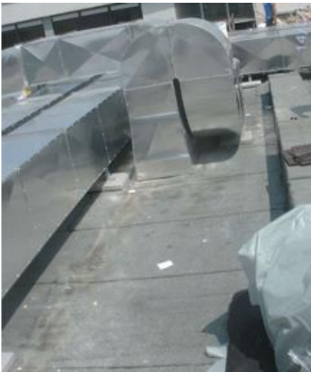
Bild: Behinderung des Zugangs zu An- und Abschlüssen Quelle: Hensler
