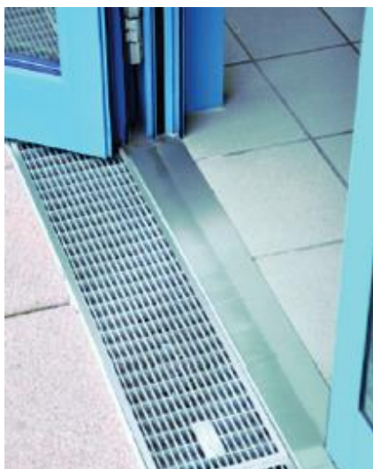
Bild: Barrierefreier Anschluss Quelle: Gutjahr
