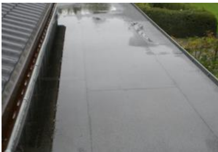
Bild: mangelndes Gefälle Quelle: Held
