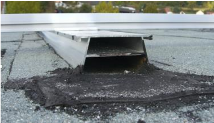
Bild: Einbindung von Schienen für aufgeständerte Solaranlagen; Quelle: J. Rühle
