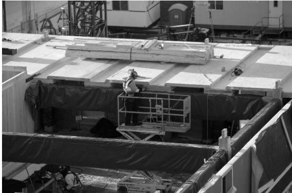
Abbildung 23: Deckensystem mit Hohlräumen für Installationen [12]
