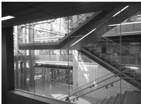
Abbildung 23: Freitragende Treppe ohne seitliche Verbindung zum Gebäude [12]
