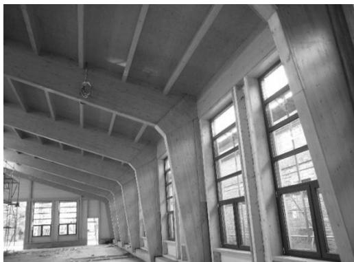
Abbildung 11: Rahmenecke mit einer Feuerwiderstandsdauer von 30 Minuten [5]
