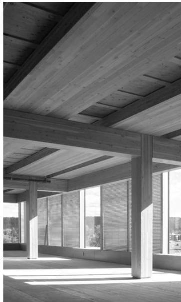
Abbildung 26: Brettsperrholz-Decken-Paneele auf einem Ske-lett aus Brett-schichtholz [16]
