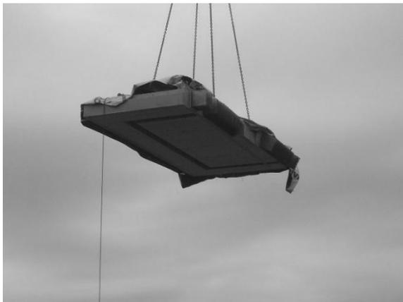
Abbildung 20: Vorgefertigte Treppenelemente [12]
