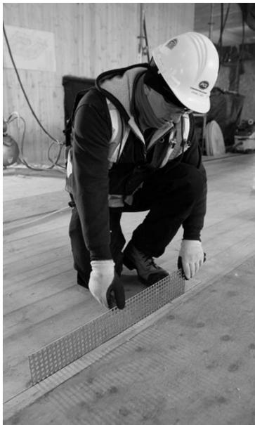
Abbildung 25: Einschleiben der Verbinders von der Oberseite [12]
