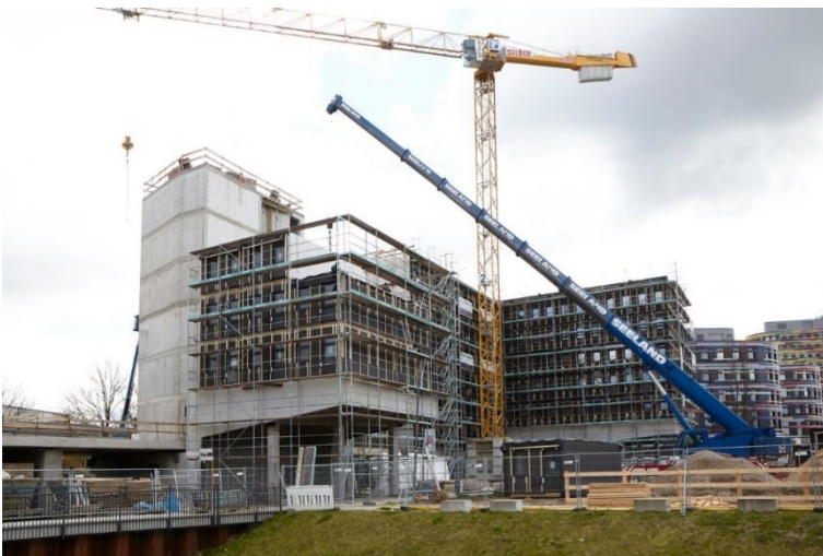
Abbildung 12: Baustelle in Hamburg
