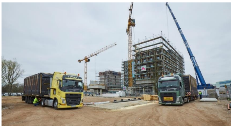
Abbildung 14: Anlieferung der Module
