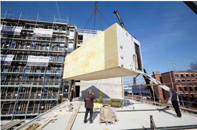
Abbildung 11: Modulmontage
