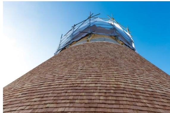
Abbildung 28: Schindeldeckung Kapelle
