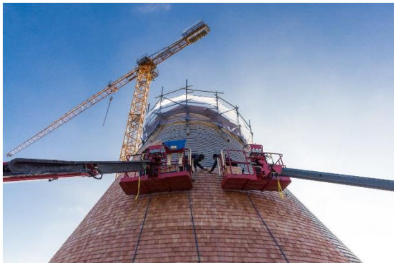
Abbildung 27: Schindelmontage Kapelle
