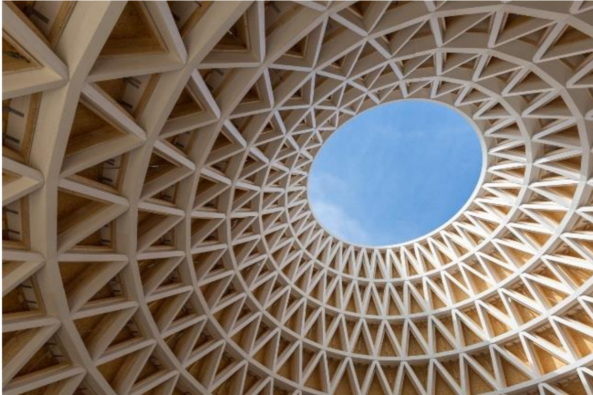
Abbildung 26: Innenansicht nach Montage Firstring
