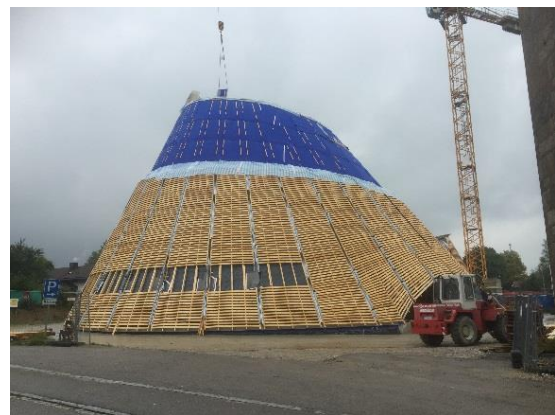
Abbildungen 25: Witterungsschutz während der Montage Ansichten von innen und aussen
