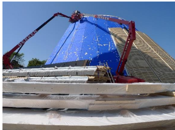
Abbildung 22: Lagerung auf der Baustelle
