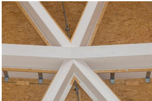
Abbildung 20: Knotenpunkt mit Zugstange + Zuglaschen
