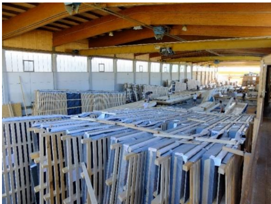
Abbildung 19: Vorfertigung der Dachelemente
