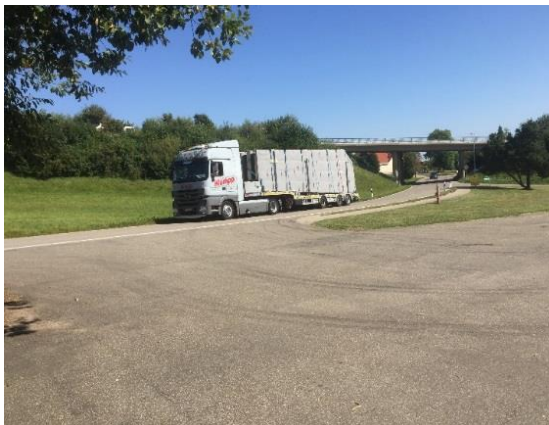
Abbildung 21: Transport der Dachelemente
