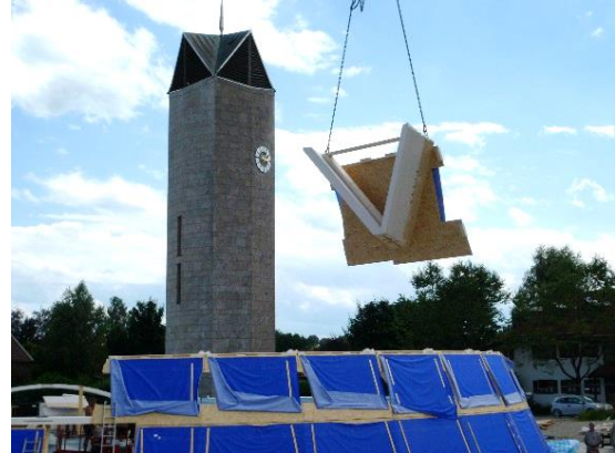
Abbildung 24: Montage Strebenelement
