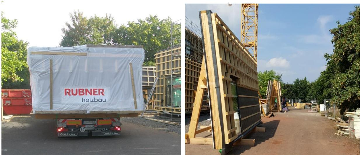
Abbildung 7 und 8: Sondertransport Fassadenelemente und A-Bock zur Fertigmontage
