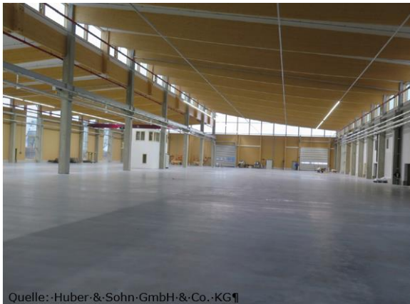
Abbildung 1: Gewerbebau in Holzbauweise
