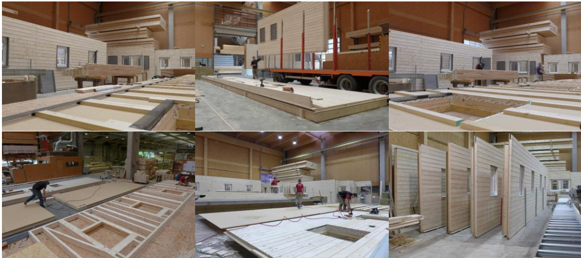
Abbildung 6: Vorfertigung Werk Meiberger
